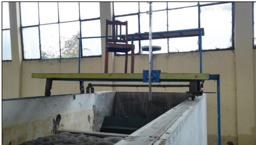
Figura N° 3.8 Limnómetro instalado en puente móvil sobre canal de trabajo. Fuente: Propia
