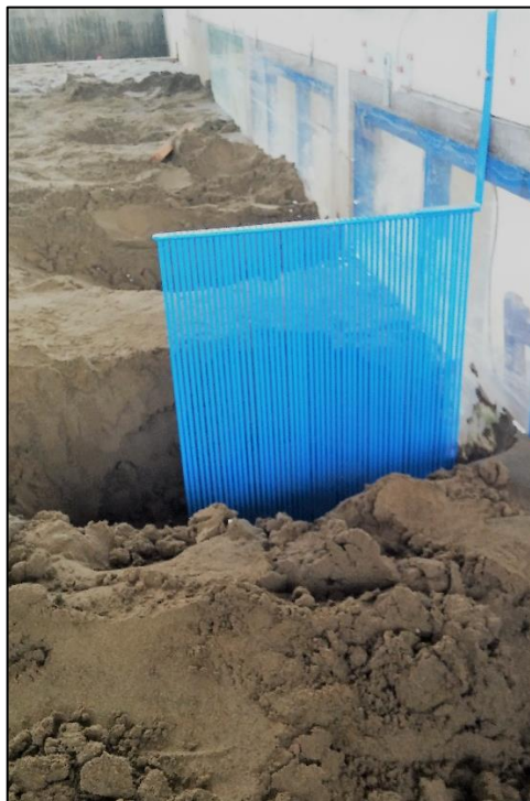
Figura N° 3.23 Colocación de espigón de prueba. Fuente: Propia
