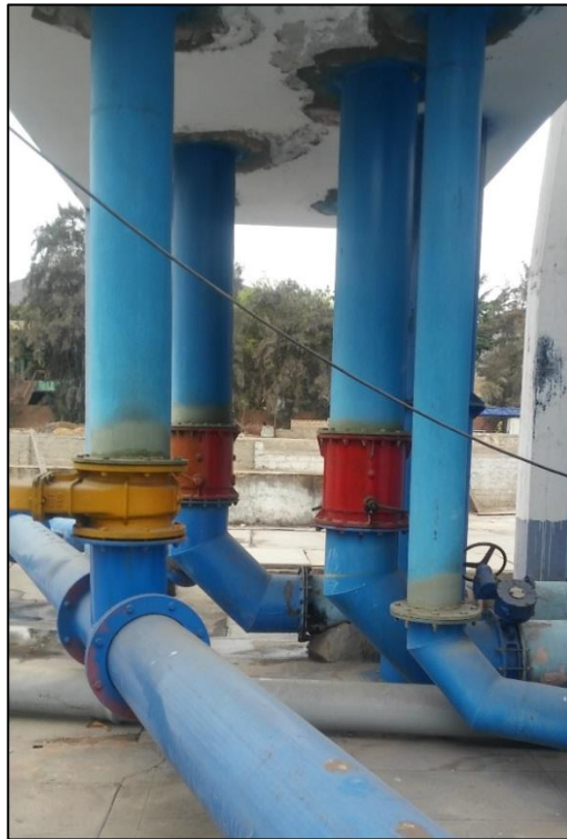
Figura N° 3.2 Fotografía de reservorio principal. Fuente: Propia
