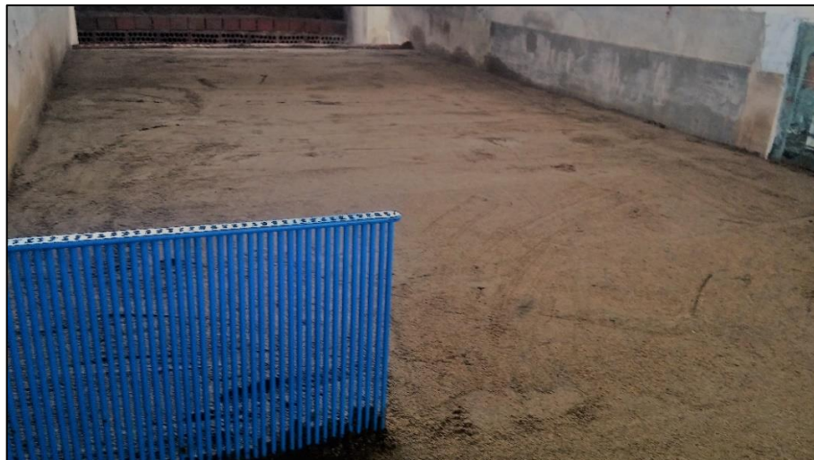
Figura N° 3.24 Conformación de lecho. Fuente: Propia
