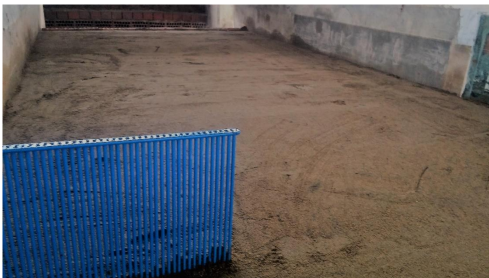
Fotografía N° D.4. Conformación final de lecho de canal de ensayos. Se utilizó el nivel topográfico para lograr una pendiente de fondo exacta. Se tuvo especial cuidado en los alrededores del espigón de prueba a fin de no afectar su permeabilidad básica. El sentido de flujo en la fotografía es de arriba hacia abajo.
