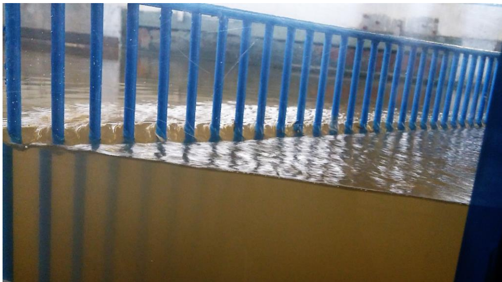
Fotografía N° D.7. Paso de flujo a través del cuerpo permeable del espigón. Se aprecia el efecto de pérdida de energía local provocado por el cuerpo permeable del espigón y el paso del flujo a través de su ancho efectivo. El flujo desacelera aguas arriba del espigón y acelera al traspasarlo. El sentido de flujo en la fotografía es de izquierda a derecha.
