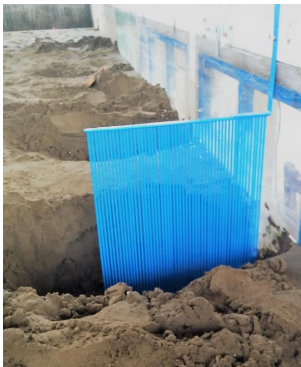
Fotografía N° D.3. Colocación del espigón de prueba en el canal de ensayos. Se tuvo que tener mucha precisión para la colocación de estas estructuras, pues se necesitaba obtener una orientación y nivel de empotramiento exacto. Se compactó el lecho por capas delgadas en las proximidades del espigón para una mejor fijación.
