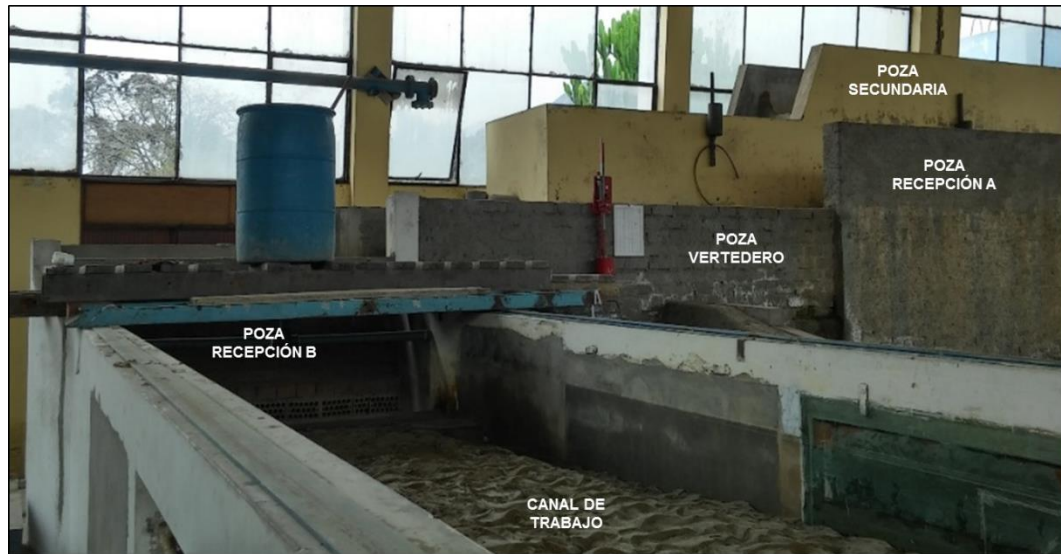
Figura N° 3.4 Canal de trabajo. Fuente: Propia
