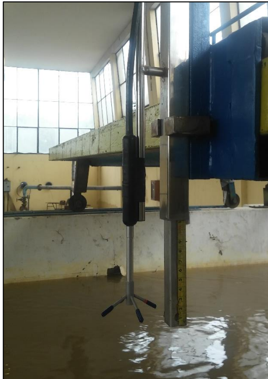
Figura N° 3.10 Velocímetro perfilador acústico de efecto Doppler. Fuente: Propia
