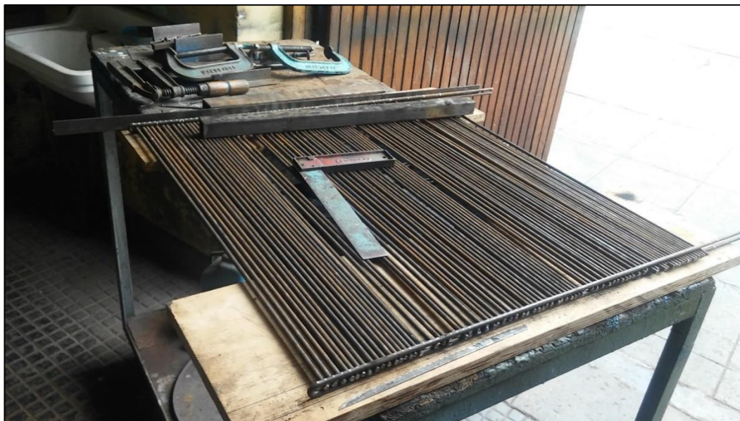
Figura N° 3.13 Varillas de acero en la construcción de espigones. Fuente: Propia
