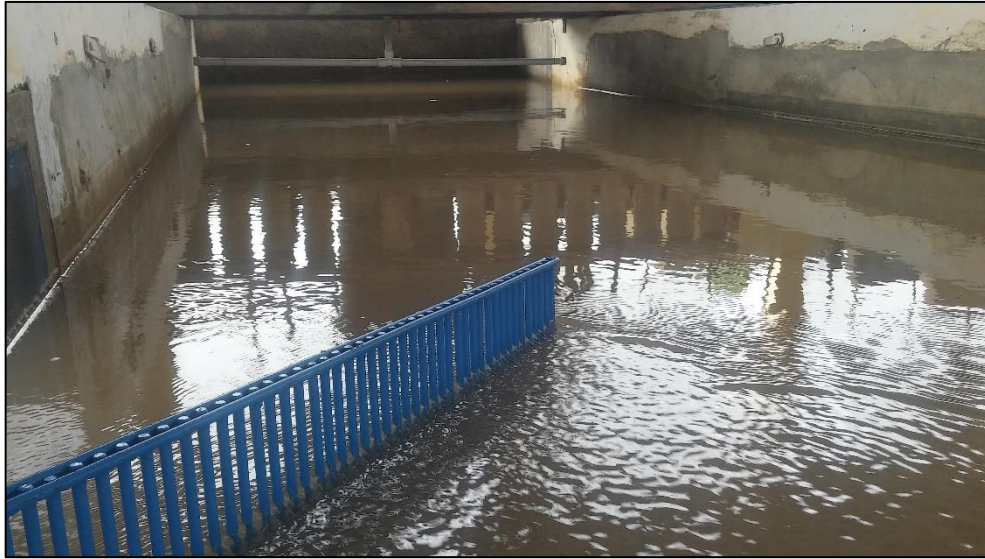
Figura N° 3.27 Fijación del caudal de flujo. Fuente: Propia
