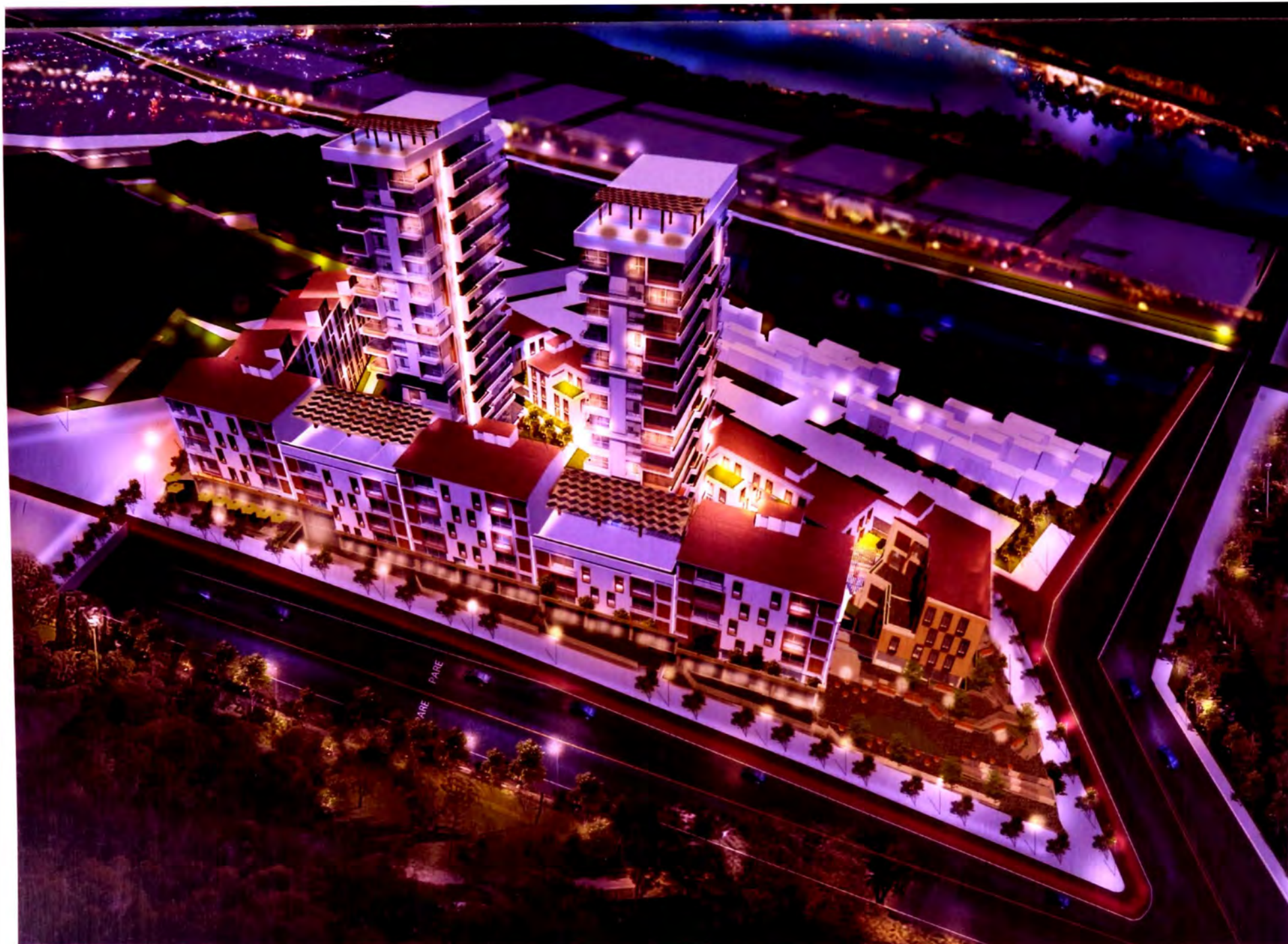
Vista aérea desde el parque central, se observa el área comercial sobre la Av. Mario Accinelli y la plaza pública
