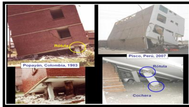
Figura N° 2.24 Colapso de dos edificios en los terremotos de Colombia en 1983 y Pisco en 2007 debidos de la presencia de piso blando en el primer nivel de la estructura
