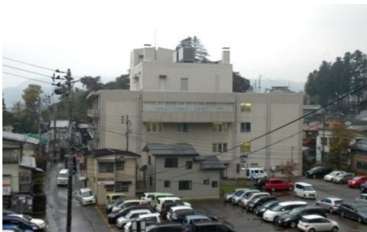
Figura N° 1.9 Hospital General de Ojiya reforzado con aislamiento sísmico (Fuente: Reyna R., 2012)
