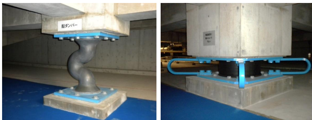
Figura N° 1.8 Elementos de amortiguamiento Izq.: Fusible de plomo. Der.: Fusible de Acero. (Fuente: Reyna R., 2012)
