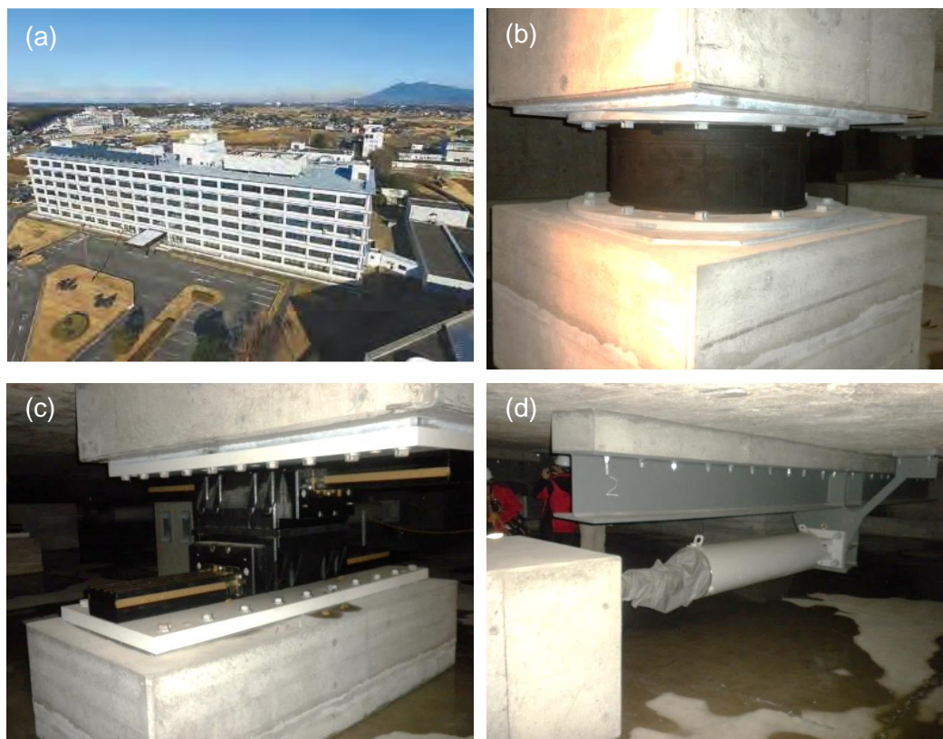
Figura N° 1.11 Edificio reforzado del GSI, Japón
