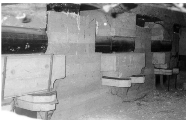
Figura N° 1.2 Primer sistema de aislamiento en el mundo (Fuente: Garevski y Kelly, 1998)
