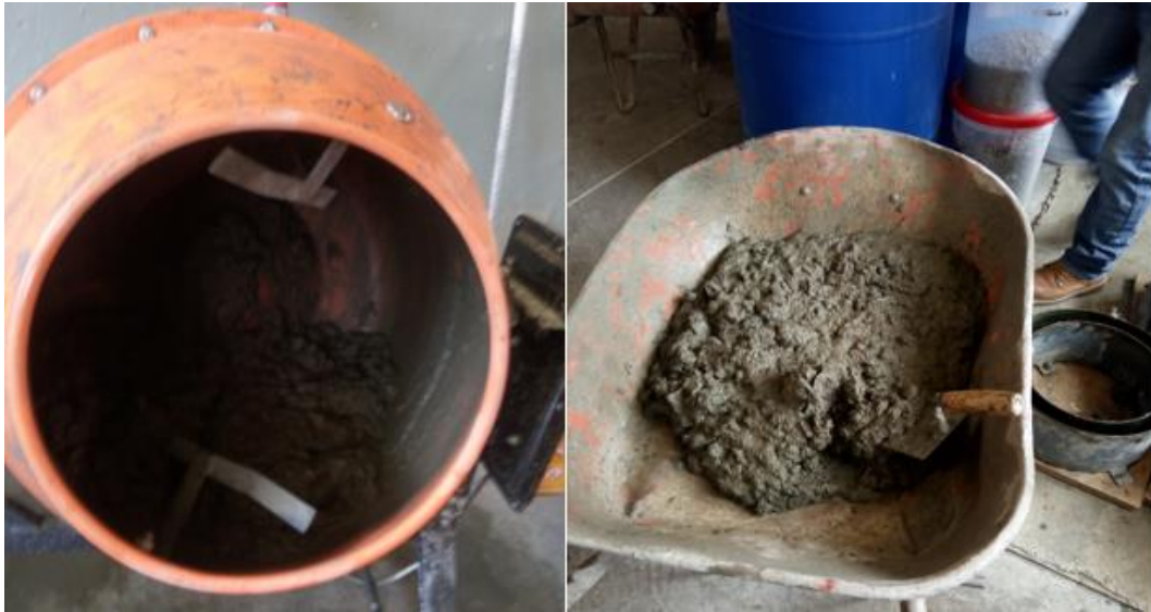
Figura N° F.0.9. Preparación del concreto fresco.
