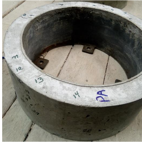
Figura N° 7.6. Fisuras superficiales y laterales enumeradas.
