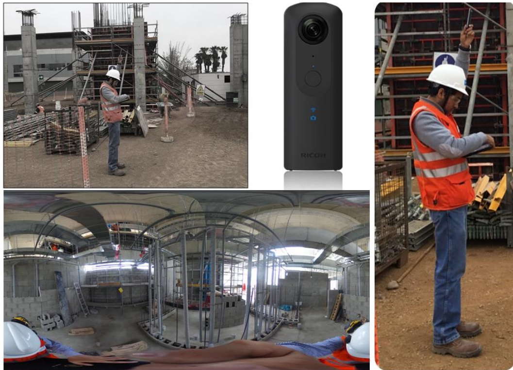
Figura 79: Uso de cámaras 360° para el seguimiento de los trabajos de los subcontratistas en los ambientes dentro de los recintos (Fuente: Cosapi)
