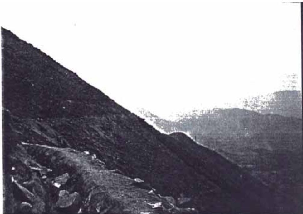
FOTO N o 8.- Canal construido por los pobladores sin asistencia técnica con la finalidad de aprovechar el excedente de la Central Hidroeléctrica de Moyopampa para luego contar con terrenos agrícolas
