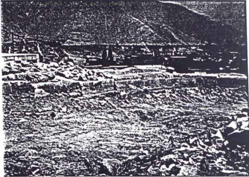
Foto 11: Este muro se contruyo como medida de defensa, pero no cuenta con la suficiente altura como para evitar un huayco mediano ante la eventualidad de sufrir una obstrucción.
