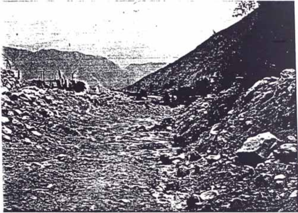
Foto 13: vista de la profundización artificial del cauce para poder manejar un posible futuro huayco.
