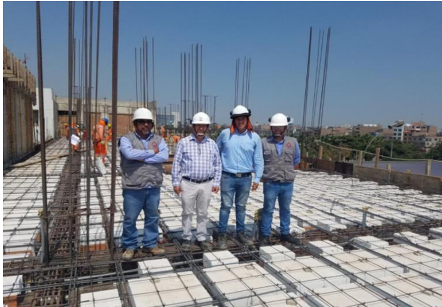
Figura N° 27 Inspección de las observaciones encontradas en obra
