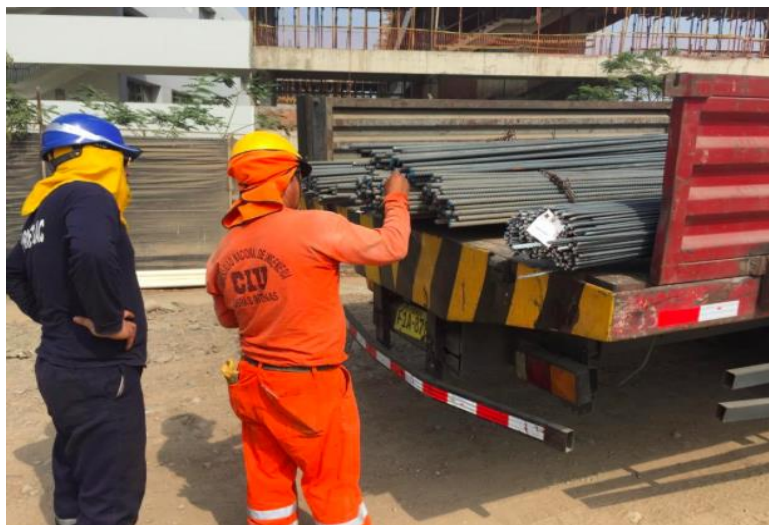
Figura N° 22 Inspección de las varillas de acero llegadas a obra
