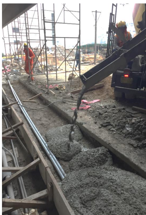
Figura N° 31 Frente habilitado para colocar el sobrante de concreto
