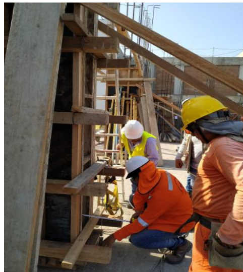
Figura N° 25 Control de Liberación de encofrado
