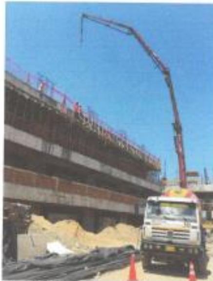
Figura 2: Terminó de instalación en obra del Camión Bomba Pluma (11:10am)
