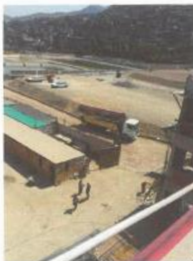
Figura 1: Llegada del Camión Bomba Pluma (10:22am)
