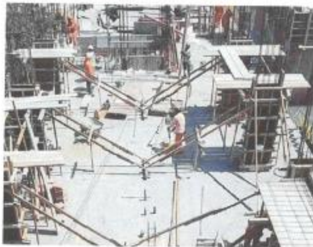
Figura 3: Instalación de las tuberías adicionales de la Bomba Pluma (1:08pm)
