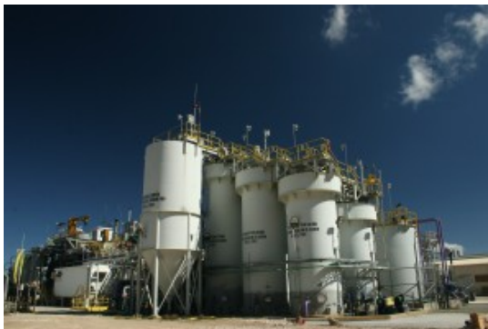
Figura N°09: Columnas de carbón
