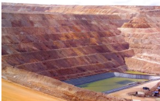
Figura N°5: Pad de Lixiviación
