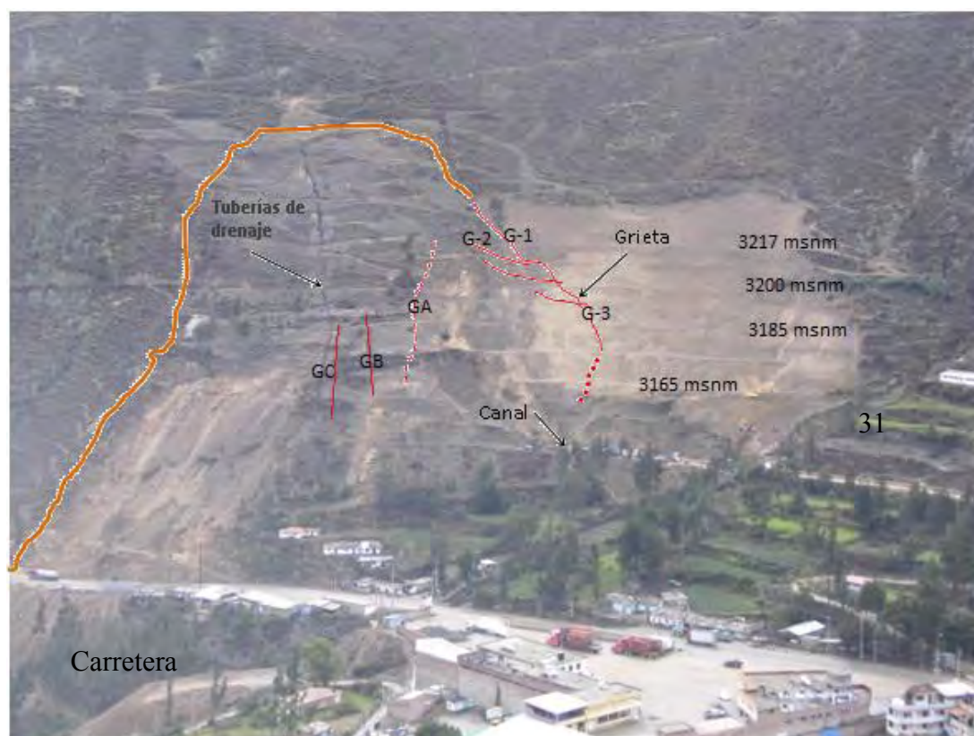
Figura 0.46 Vista de los trabajos de retaludamiento y la grieta principal
