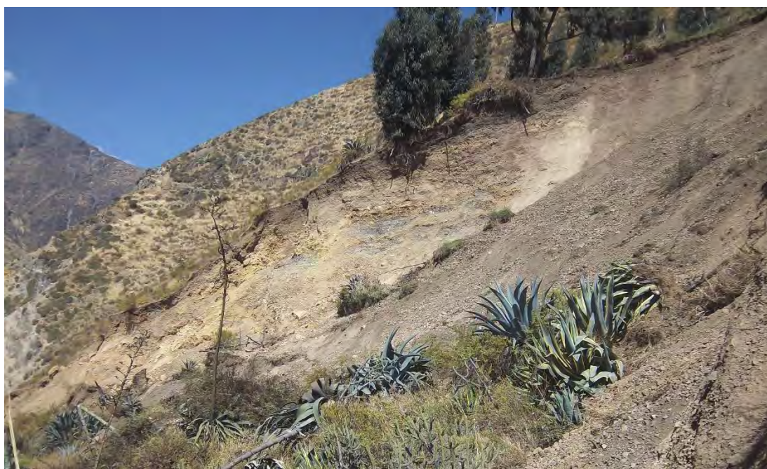
Figura 0.13 Vista del macizo rocoso alterado el 17/08/2011 luego del deslizamiento
