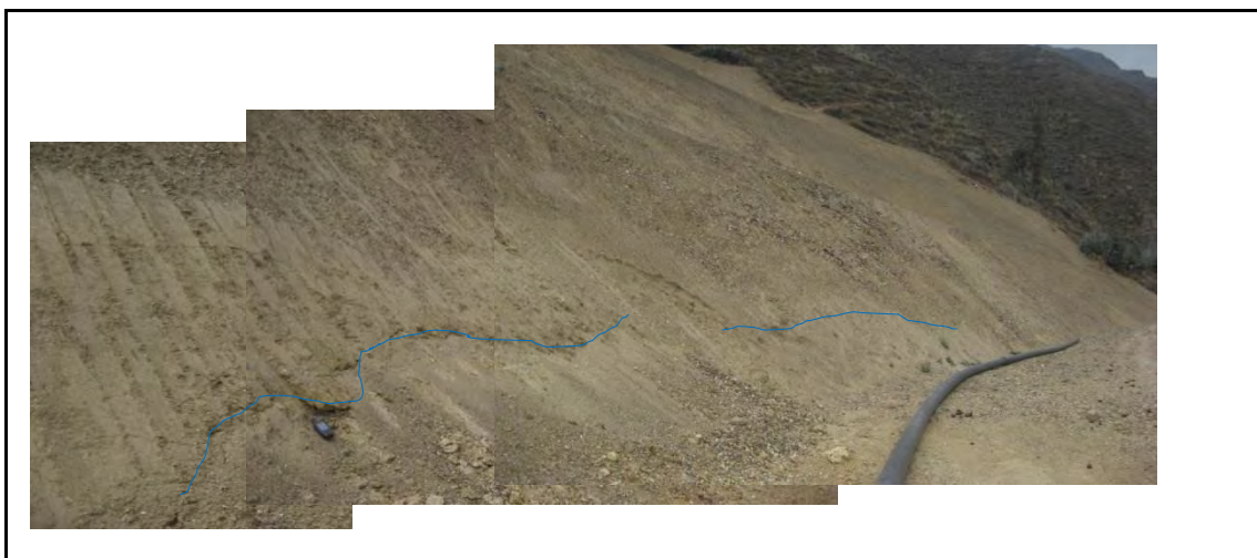
Figura 0.49 Plano de falla del antiguo deslizamiento en el talud de cota 3195 msnm el 10/11/13
