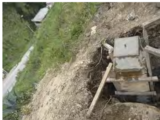
Figura 0.13 Construcción de un hito de control
