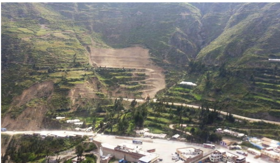
Figura 0.10 Vista del deslizamiento en noviembre 2013
