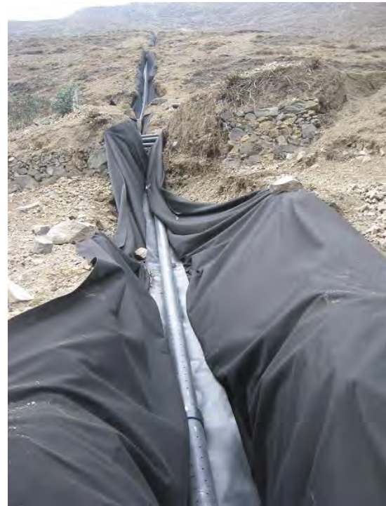
Figura 0.56 Materiales para el drenaje, tubería perforada y geotextil
