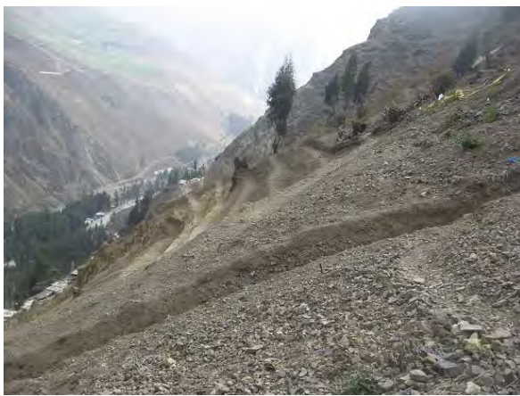
Figura 0.57 Reperfilamiento en la zona arriba del deslizamiento en agosto del 2011
