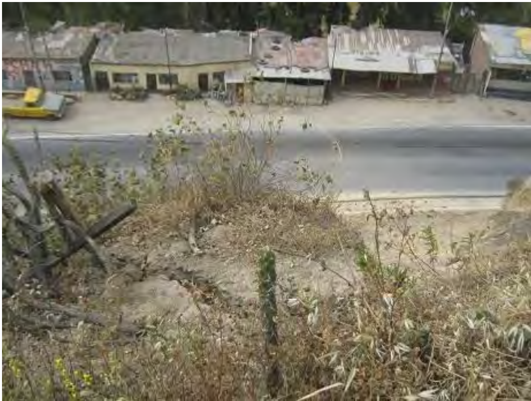
Figura 0.7 Casas ubicadas en el borde de la carretera en el mes de junio de 2011
