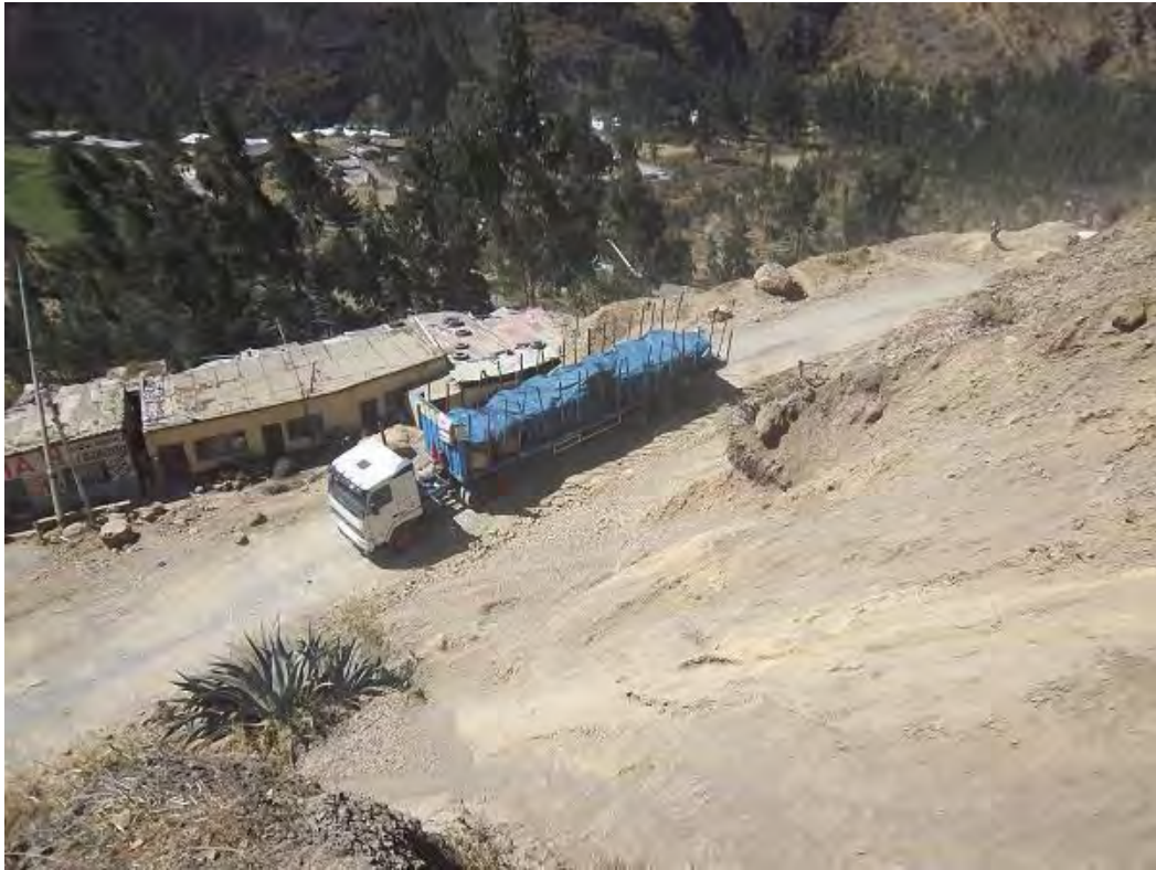
Figura 0.8 Casas cubiertas por el deslizamiento, al menos 04 casas sepultadas
