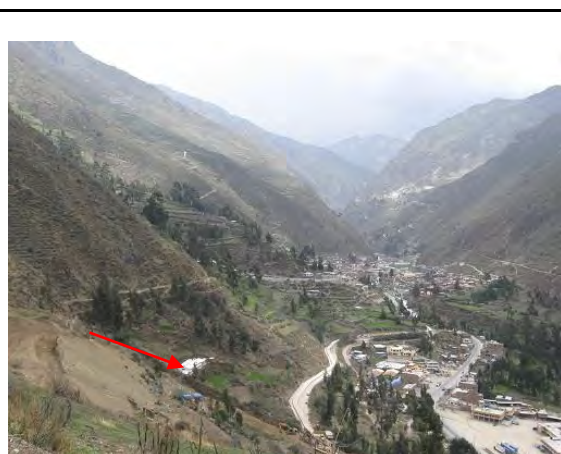
Figura 0.3 Instalaciones del sondeo S-3, en el fondo el canal y pueblo de San Mateo
