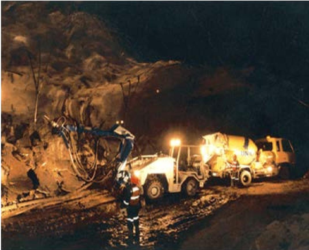
**FIGURA N° 27:** Lanzado de shotcrete via humeda proyeccion robotica con aditivos y fibras metalicas de alta tecnologia
