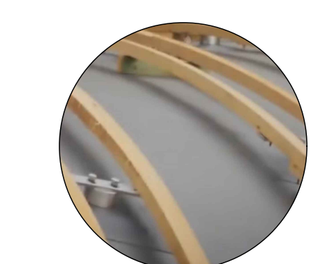
VISTA DE BASTIDORES SOBRE MANTO GEOTEXTIL
