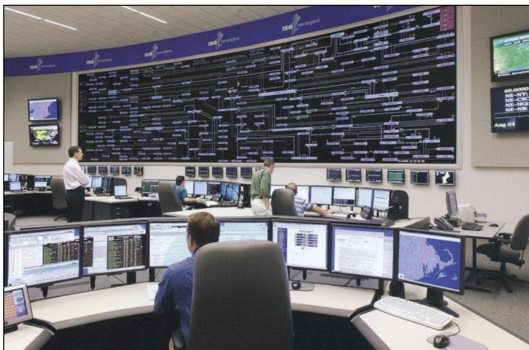
Fig. 2.2: Ejemplo de Sala de Control
