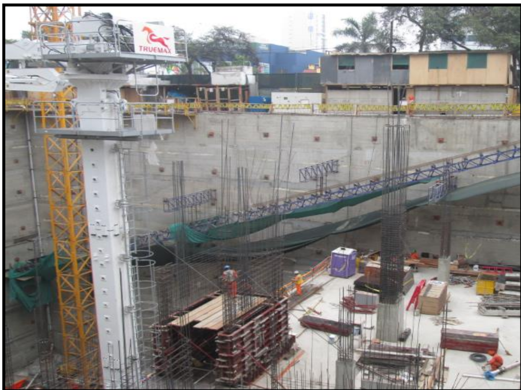
Concreto Armado Sótanos del Proyecto
