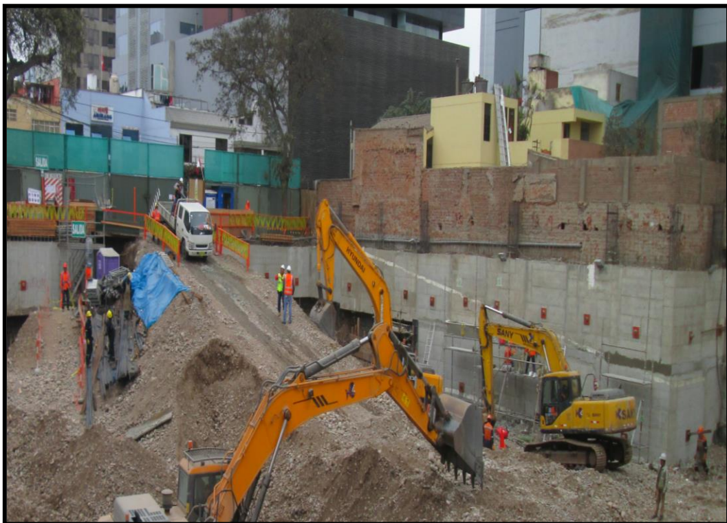
Excavación, Eliminación y Muros Anclados del Proyecto
