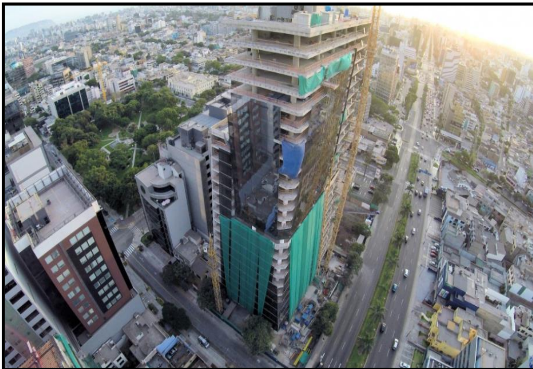
Concreto Armado Pisos Superiores del Proyecto
