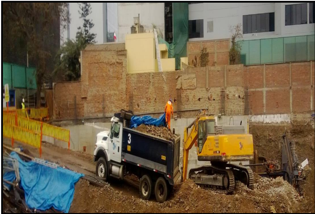
Excavación, Eliminación y Muros Anclados del Proyecto
