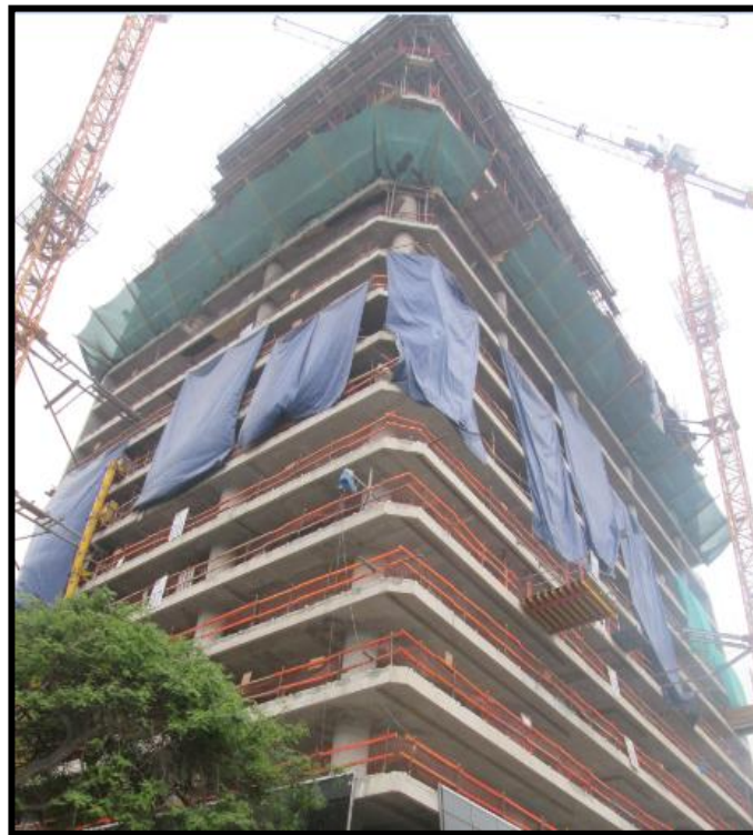
Concreto Armado Pisos Superiores del Proyecto
