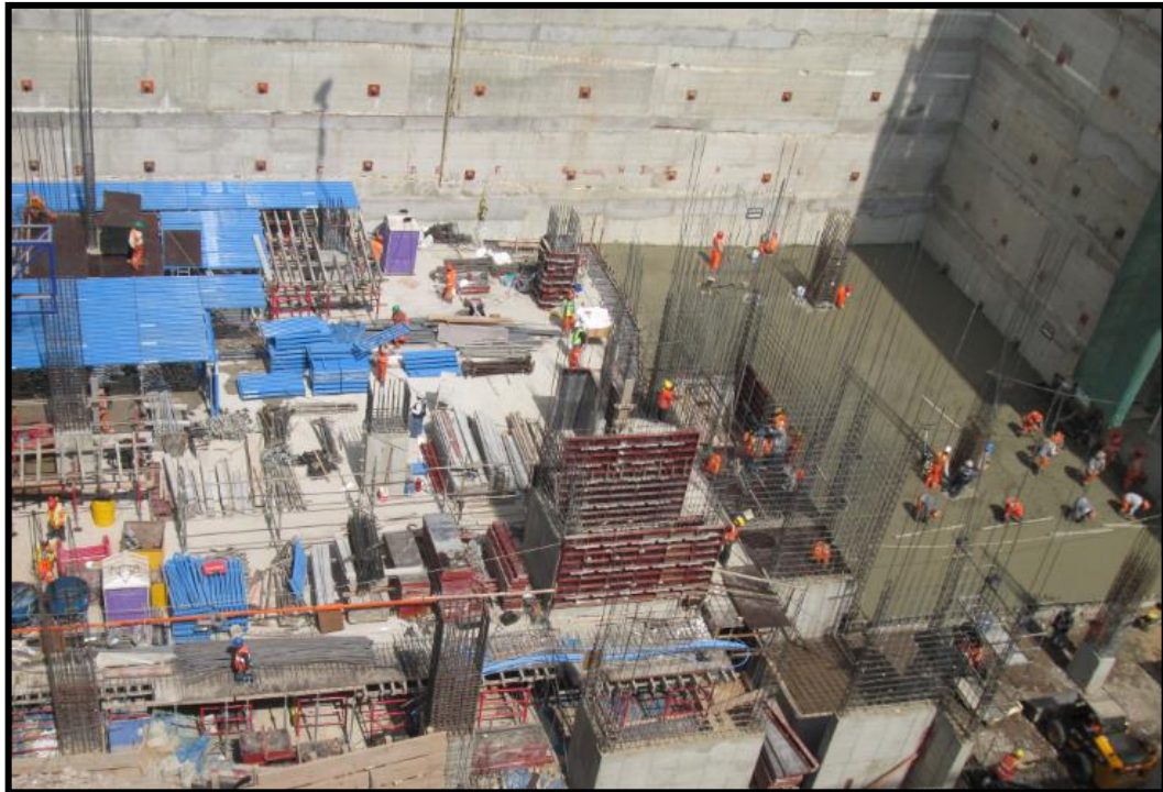
Concreto Armado Sótanos del Proyecto
