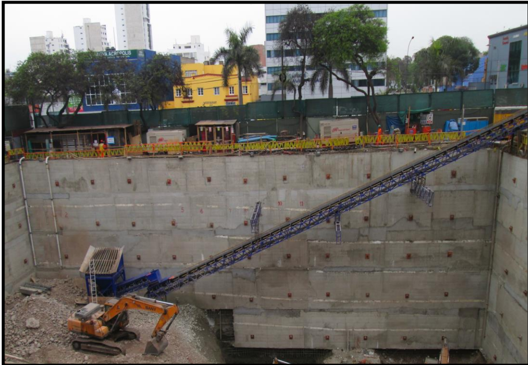
Excavación, Eliminación y Muros Anclados del Proyecto
