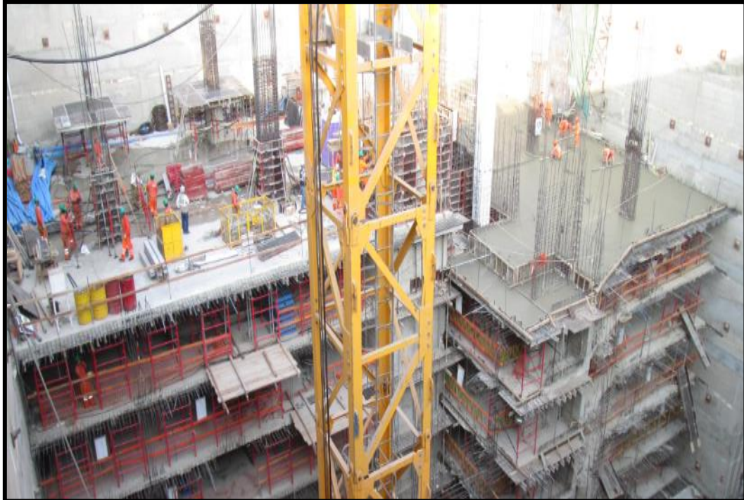
Concreto Armado Sótanos del Proyecto
