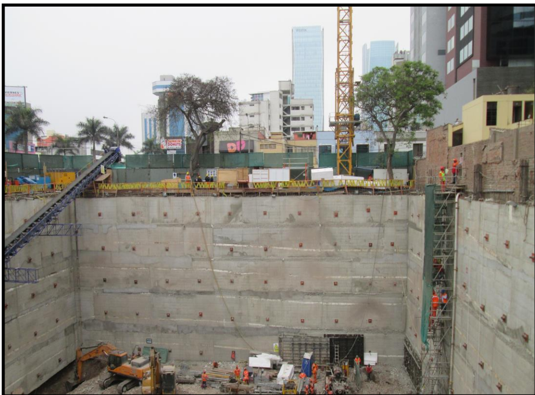
Excavación, Eliminación y Muros Anclados del Proyecto
