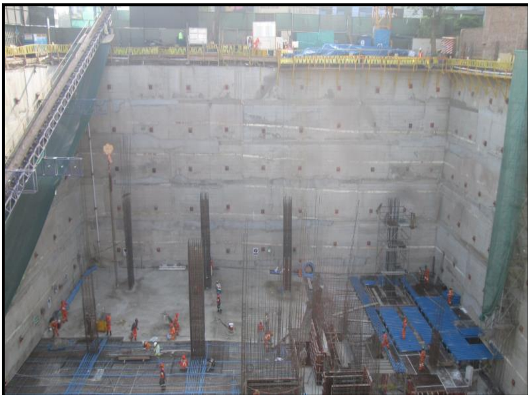
Concreto Armado Sótanos del Proyecto
