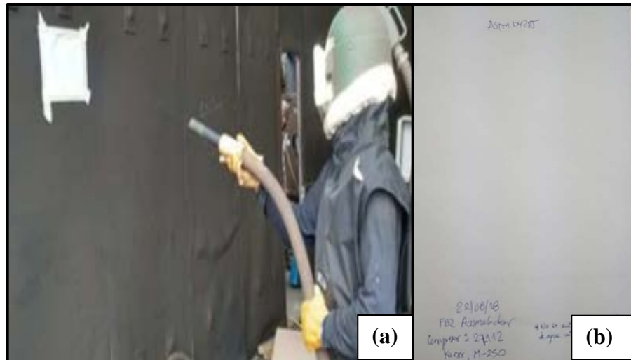
Figura 6: Prueba de calidad de aire comprimido.
