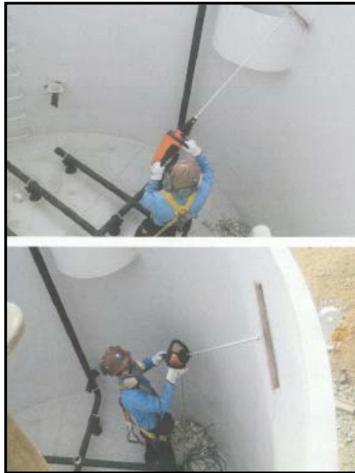
Figura 15: Evaluación de discontinuidad de película seca. Fuente: Elaboración propia.
