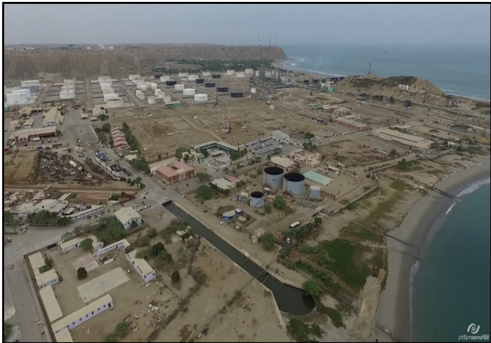
Figura 25: Refinería de Talara antes de iniciar el proyecto.
