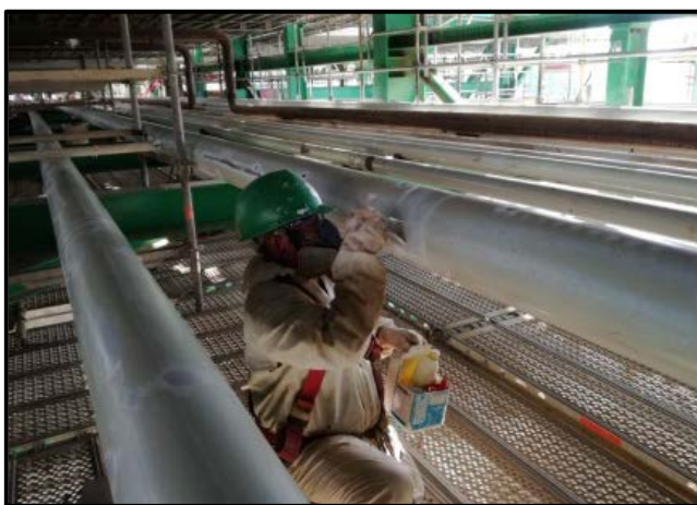
Figura 22: Aplicación de pintura fenólica con brocha. Fuente: Elaboración propia.
