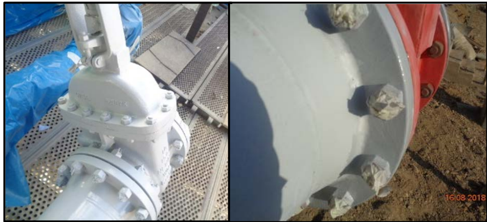
Figura 20: Cobertura de zonas aledañas antes de la aplicación de la pintura.
