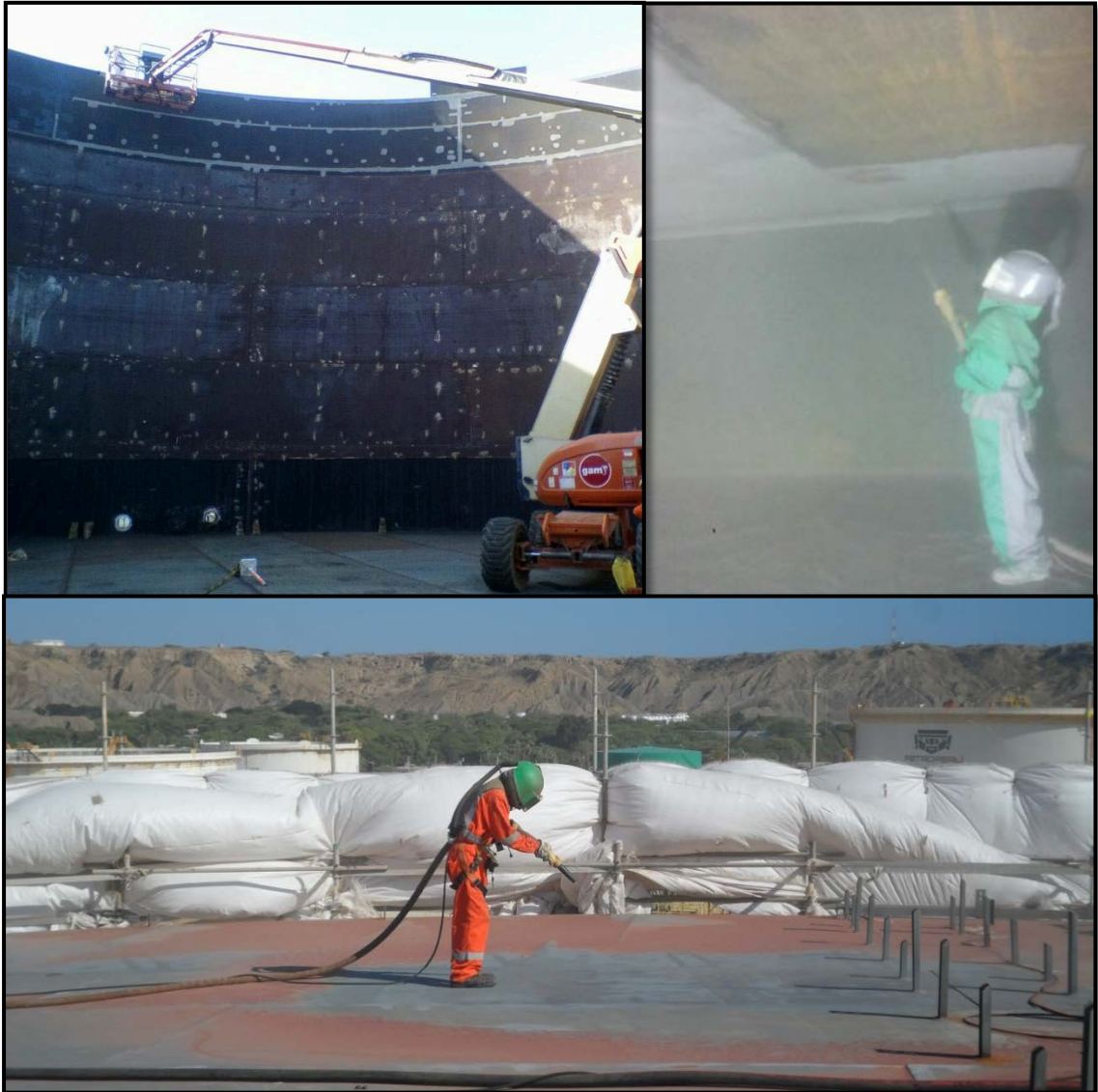
Figura 19: Preparación de superficie en interior y exterior de tanques. Fuente: Elaboración propia.
