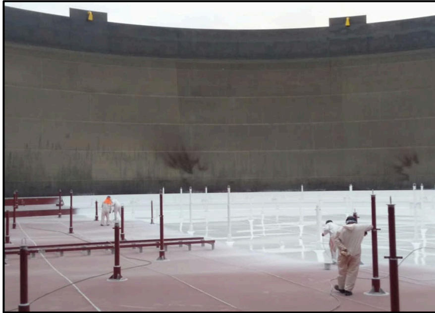
Figura 23: Aplicación de pintura con equipo airless en el exterior de tanque. Fuente: Elaboración propia.
