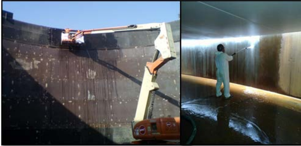
Figura 18: Lavado con agua a presión en interior de tanques. Fuente: Elaboración propia.
