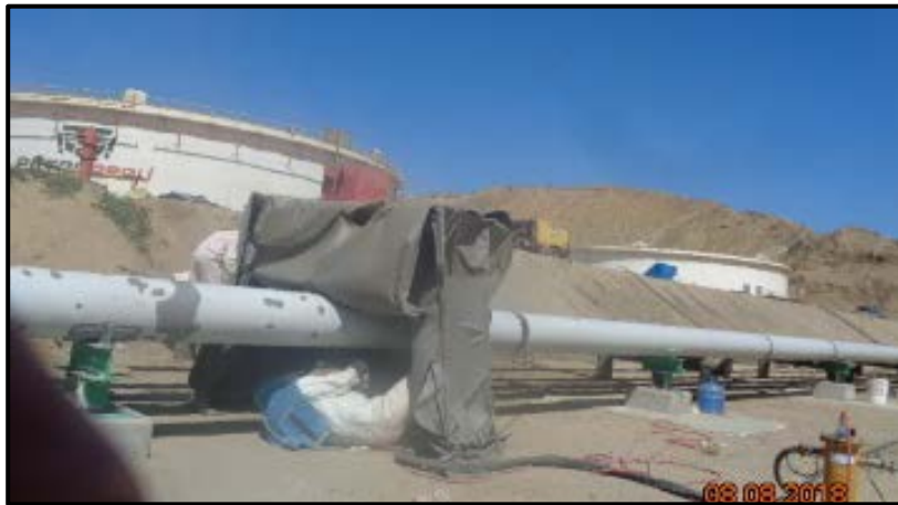
Figura 17: Coberturado del área de trabajo.
