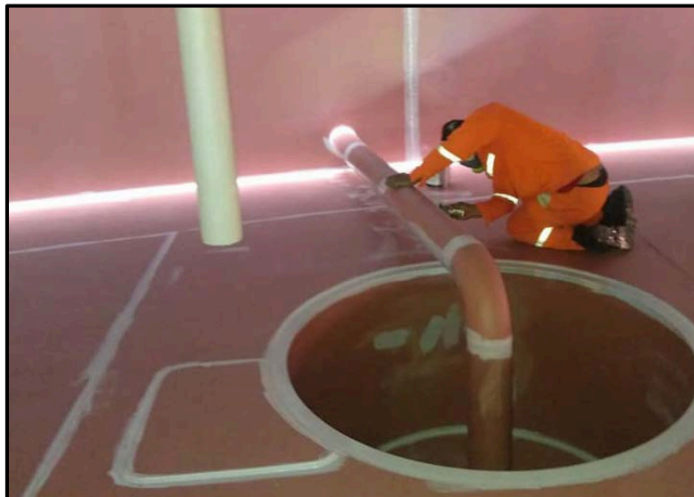
Figura 24: Aplicación con brocha de la capa refuerzo en fondo interior de tanque. Fuente: Elaboración propia.
