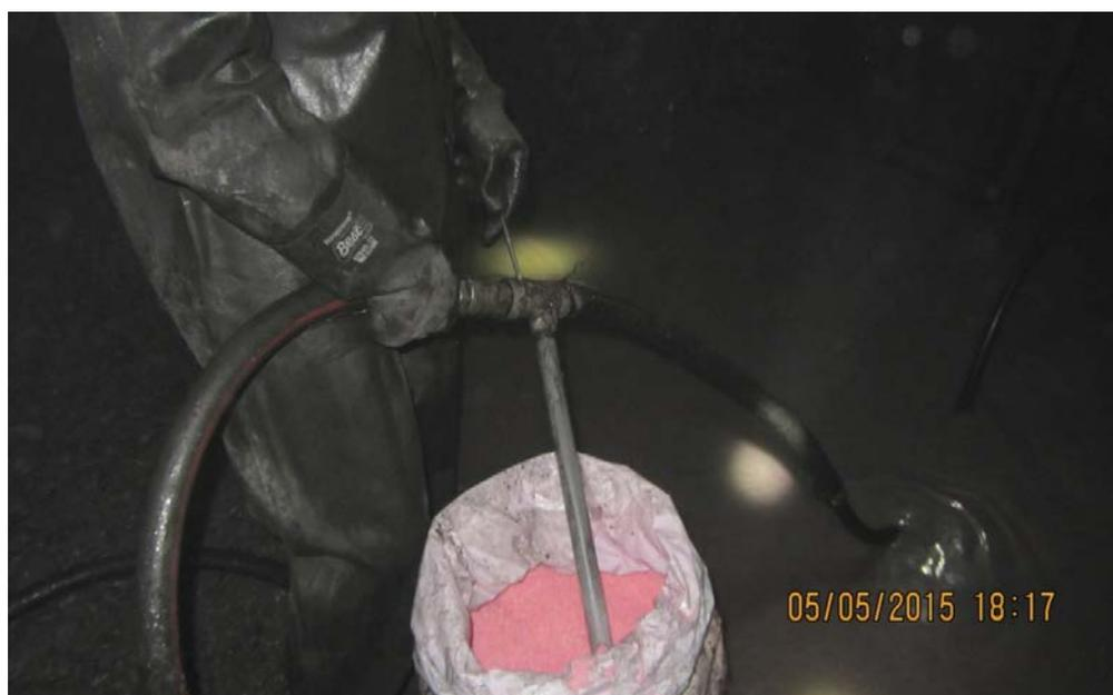
Figura N° 5.4: Muestra el ANFO listo para ser cargado en los taladros.
