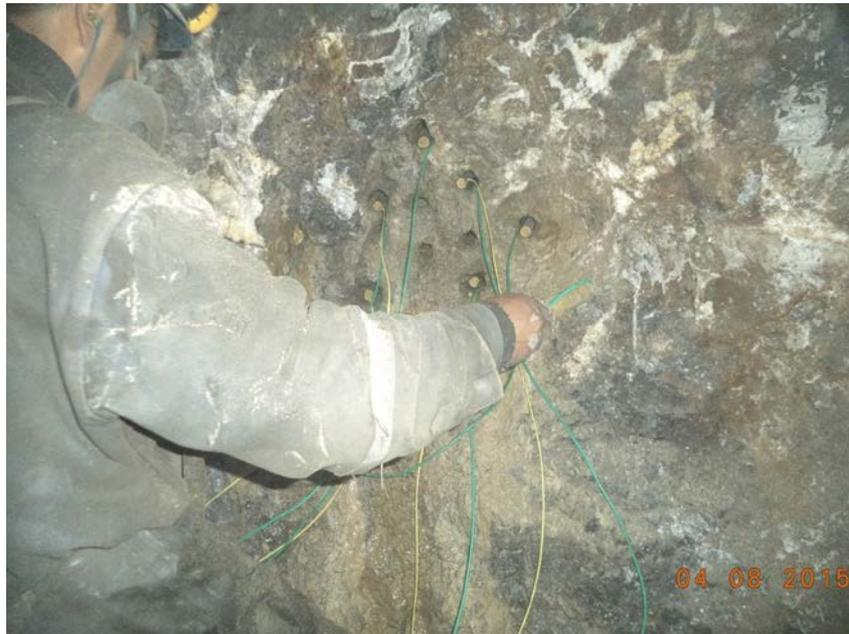
Figura N° 5.9: Muestra la conexión de los accesorios de voladura.
