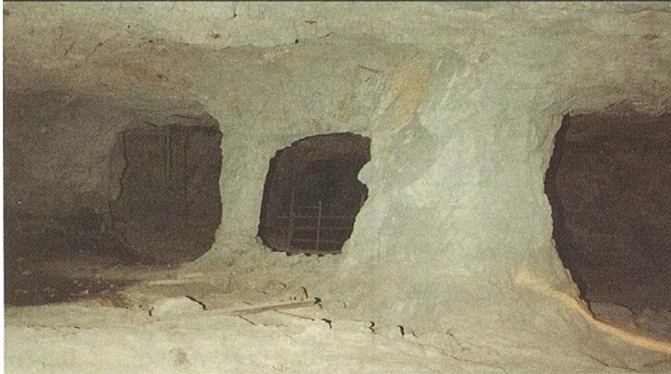
Figura N° 8.4: Muestra el auto sostenimiento del macizo rocoso.
