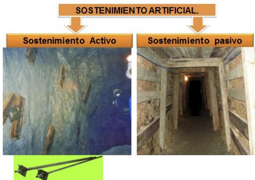
Figura N° 8.6: Muestra el sostenimiento artificial activo y pasivo.
