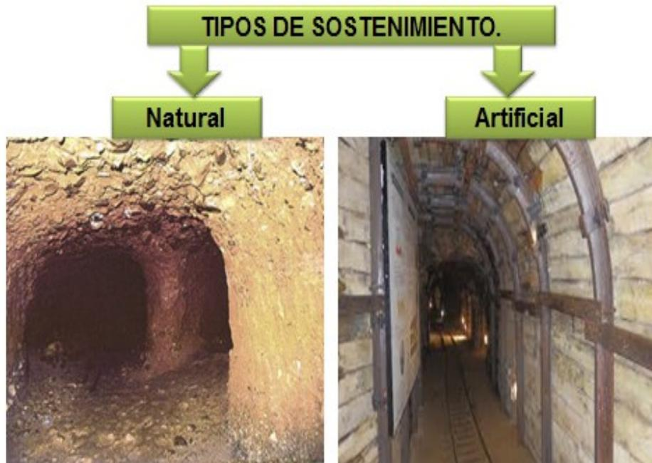
Figura N° 8.3: Muestra la clasificación general de los sistemas de sostenimiento.
