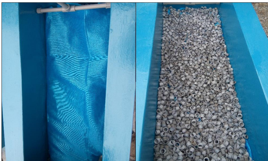
Fotografía N° 9: Colocación de medio de soporte y malla rassel.
