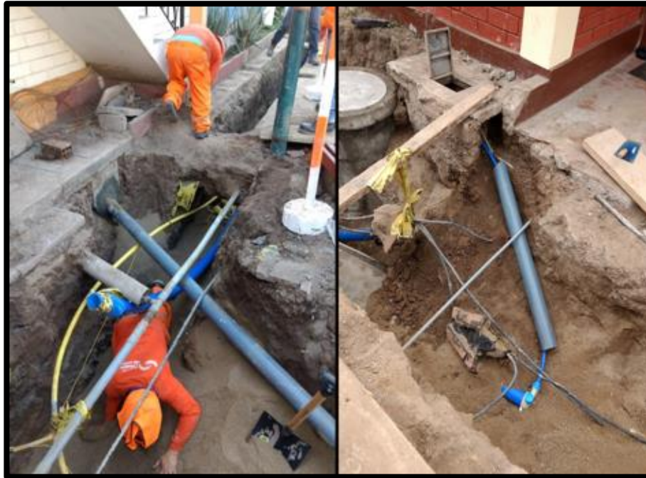
Figura N°17 Presencia de redes de energía eléctrica y gas en pasajes
