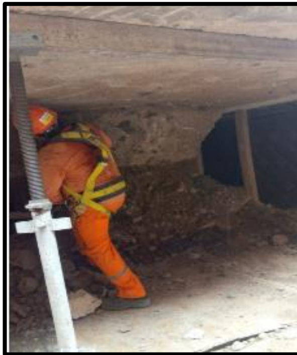
Figura N°13 Trabajos debajo de la cimentación de los reservorios (Fuente propia)
