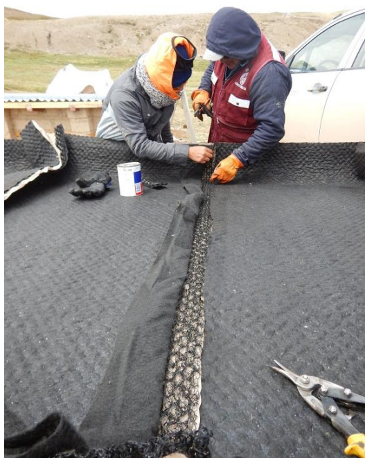
Figura IV.17. Instalación de Mac Drain.
