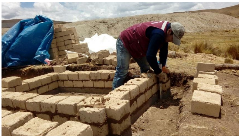
Figura IV.12. Construcción del muro de adobe.
