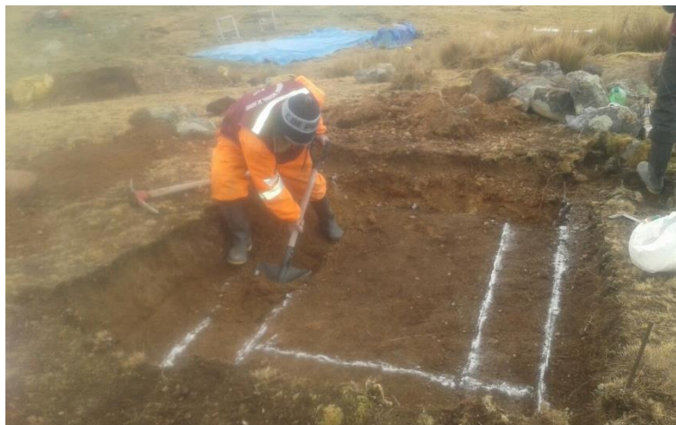
Figura IV.10. Movimiento de tierra para cimentación.
