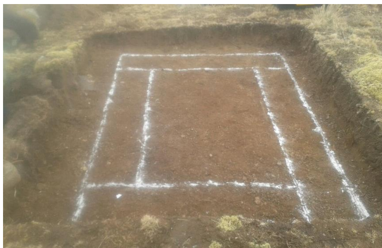
Figura IV.9. Trazo y replanteo. Fuente: (Macavilca Rojas, y otros, 2018)
