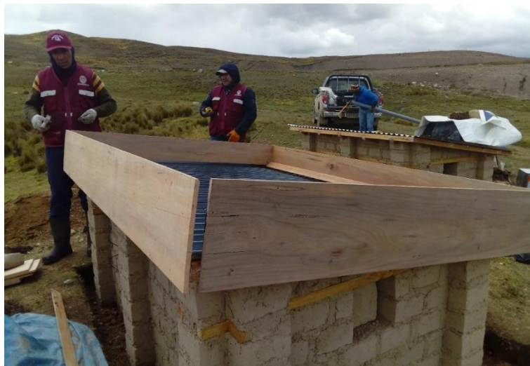
Figura IV.15. Instalación de madera perimetral para techo verde.
