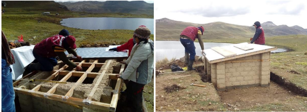
Figura IV.14. Instalación de techo con cubierta de calamina.
