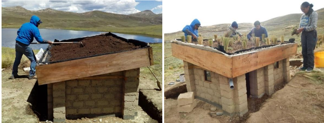
Figura IV.18. Colocación de capa de sustrato y plantación de esquejes.
