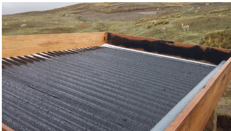
Figura IV.16. Impermeabilización con pintura bituminosa.
