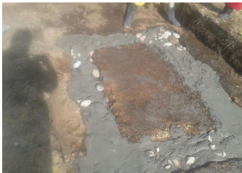
Figura IV.11. Vaciado de concreto para cimentación.
