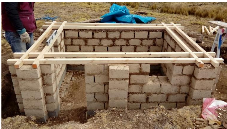
Figura IV.13. Instalación de Viga Collar – Elemento de Arriostre.
