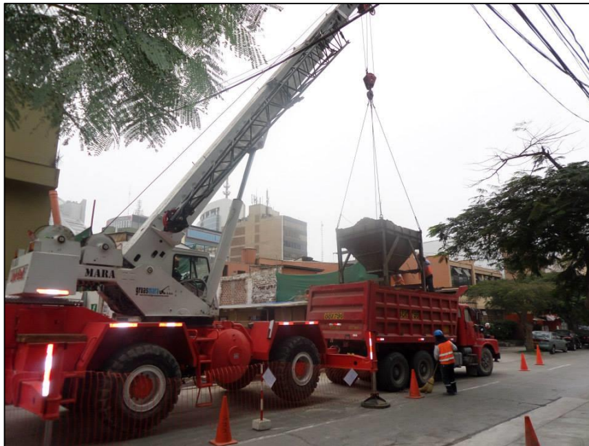
Gráfico N°4.12: 3ra Etapa - Eliminación de material excedente con balde. Fuente: Fotografía obra Edificio Tai Loy, Surquillo-Lima, 2017.
