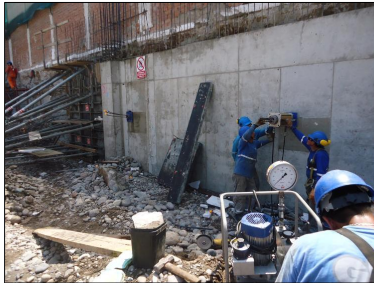
Gráfico N°4.27: Tensado de cable y medición de la elongación. Fuente: Fotografía obra Tottus San Luis-Lima, 2013.
