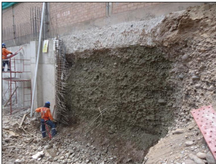
Gráfico N°4.16: Pañeteo de banqueta. Fuente: Fotografía obra Edificio Tai Loy, Surquillo-Lima, 2017.
