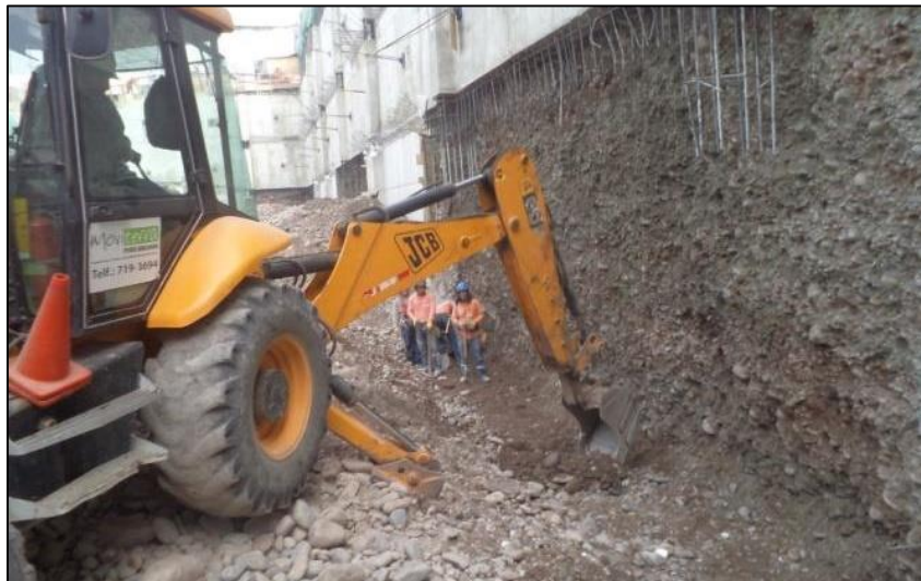
Gráfico N°4.14: Excavación localizada para cimentación. Fuente: Fotografía obra Edificio Tai Loy, Surquillo-Lima, 2017.
