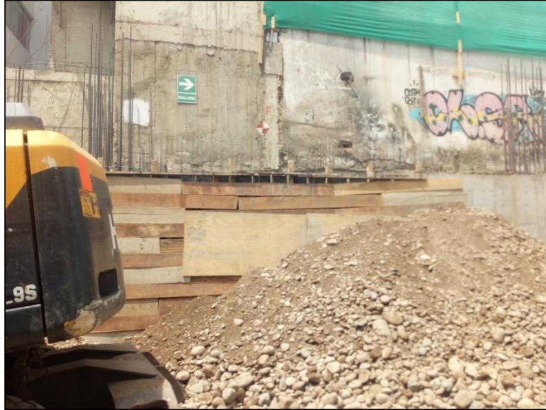
Gráfico N°4.20: Protección del encofrado con tablas. Fuente: Fotografía obra Edificio Tai Loy, Surquillo-Lima, 2017
