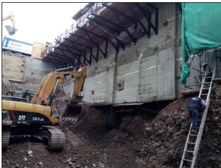
Gráfico N°4.13: Excavación localizada para banquetas. Fuente: Fotografía obra Edificio Tai Loy, Surquillo-Lima, 2017.
