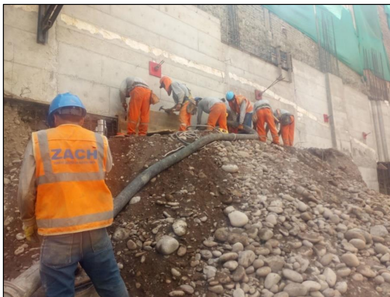
Gráfico N°4.23: Proceso de vaciado de muros de concreto. Fuente: Fotografía obra Edificio Tai Loy, Surquillo-Lima, 2017.
