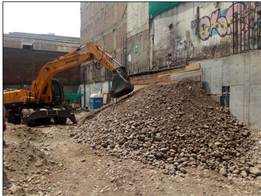
Gráfico N°4.21: Colocación de material suelto. Fuente: Fotografía obra Edificio Tai Loy, Surquillo-Lima, 2017
