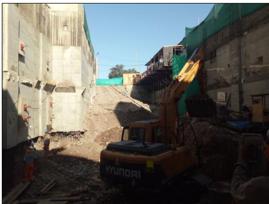
Gráfico N°4.8: Vista rampa para eliminación. Fuente: Fotografía obra Edificio Tai Loy, Surquillo-Lima, 2017.
