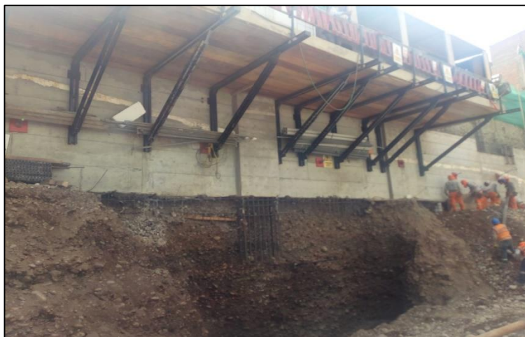
Gráfico N°4.15: Perfilado de banqueteta. Fuente: Fotografía obra Edificio Tai Loy, Surquillo-Lima, 2017.
