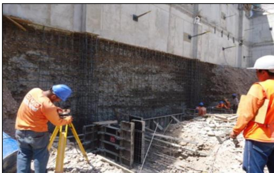
Gráfico N°4.24: Encofrado de cimentación. Fuente: Fotografía obra Tottus San Luis-Lima, 2013.
