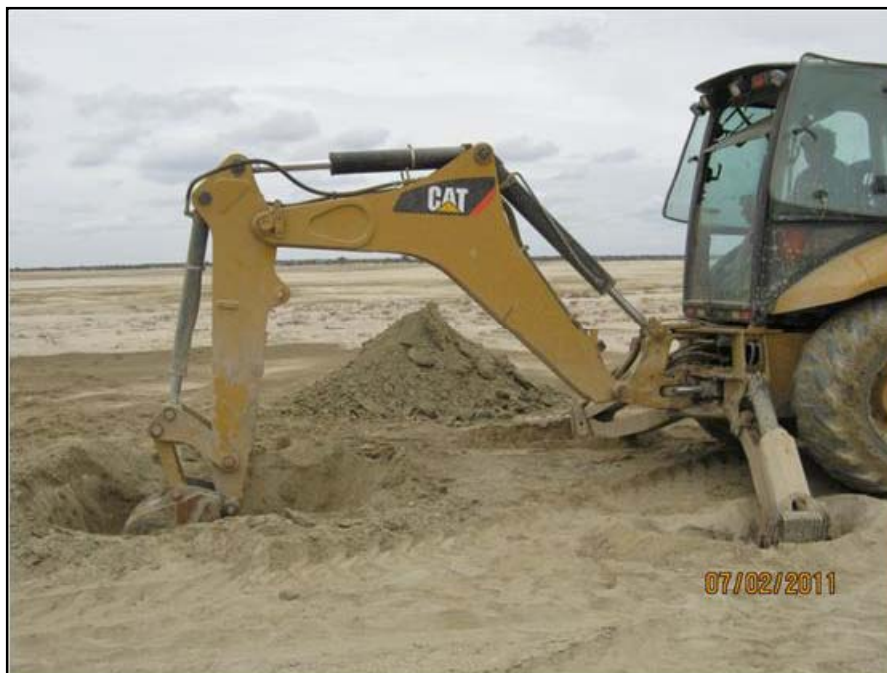
Foto N° 1 : Vista de la ubicación y ejecución de la calicata C-1. Se observa el material extraído durante la excavación.
