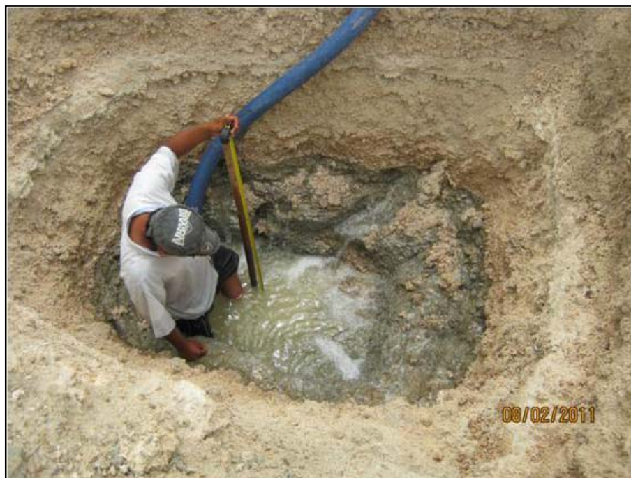
Foto N° 16 : Vista del ensayo de permeabilidad in situ por recuperación de caudal, realizado en la calicata C-4.
