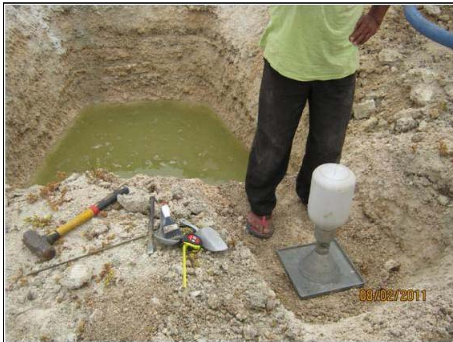
Foto N° 14 : Vista de la ejecución del ensayo de densidad de campo realizado a diferentes profundidades en la calicata C-4.
