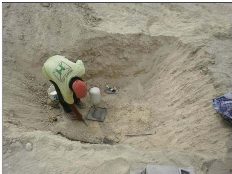
Foto N° 24 : Vista de la ejecución del ensayo de densidad de campo realizado a diferentes profundidades en la calicata C-6.
