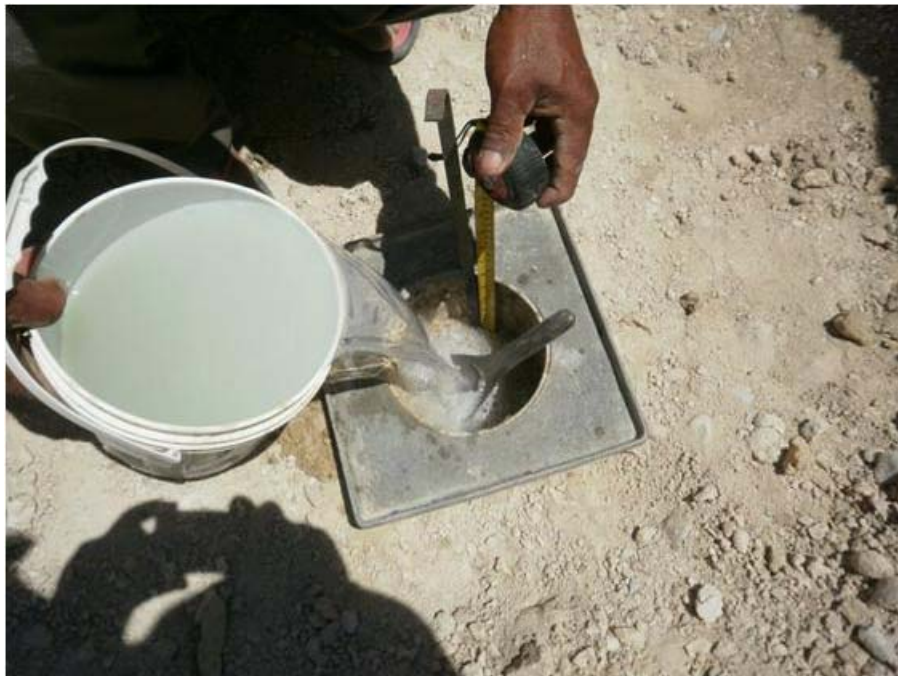
Foto N° 30: Vista de la ejecución del ensayo de permeabilidad in situ por carga variable, realizado a diferentes profundidades en la calicata C-7.
