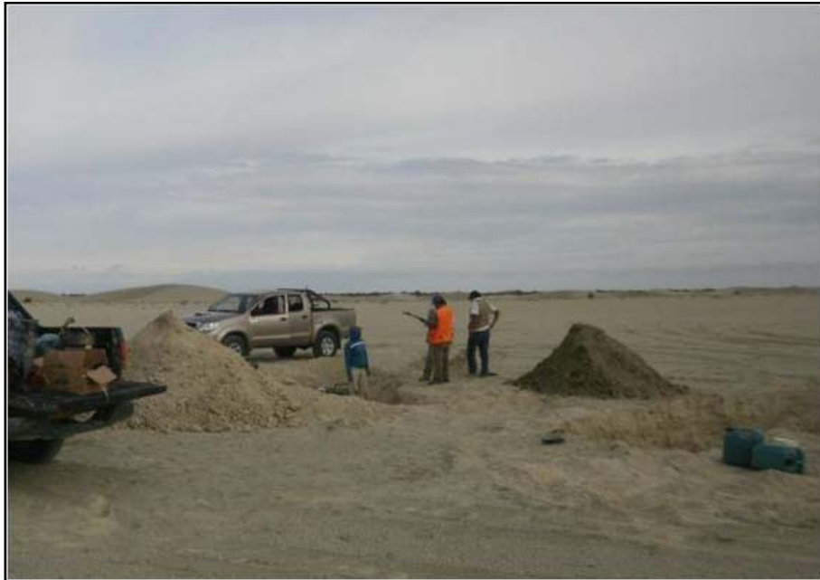
Foto N° 23 : Vista panorámica de la ejecución de la calicata C-6. Se observa el material extraído durante la excavación. El nivel freático se encontró a la profundidad de 2.45 m.
