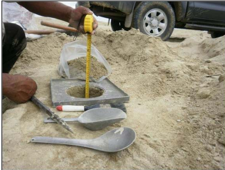
Foto N° 3 : Vista de la ejecución del ensayo de densidad de campo, realizado a diferentes profundidades a lo largo del perfil de la calicata C-1.
