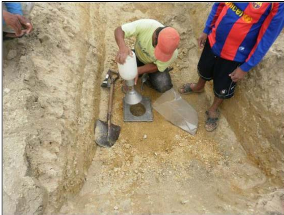
Foto N° 19 : Vista de la ejecución del ensayo de densidad de campo, realizado a diferentes profundidades en la calicata C-5, se observa el material extraído durante el ensayo.
