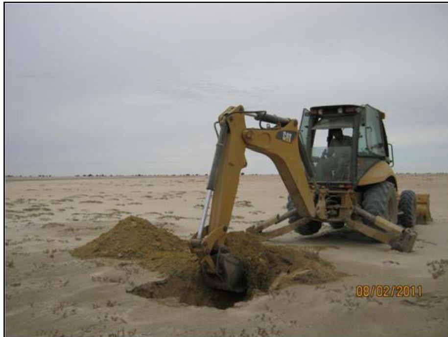
Foto N° 17 : Vista de la ubicación y ejecución de la calicata C-5. Se observa el material extraído durante la excavación.
