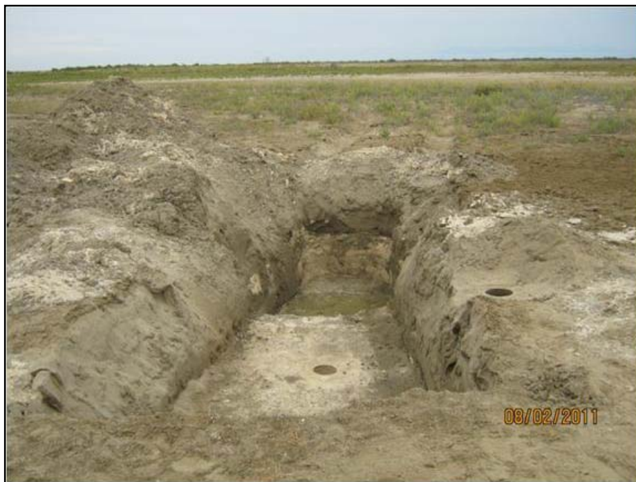
Foto N° 5 : Vista Panorámica de la calicata C-2 ejecutada a un costado de la calicata C-3, se observa la presencia del nivel freático.
