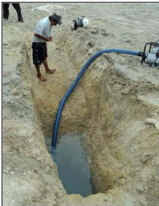
Foto N° 22 :Otra vista de la ejecución del ensayo de permeabilidad in situ por recuperación de caudal, realizado en la calicata C-5.
