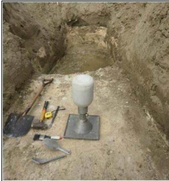
Foto N° 9 : Vista de la ejecución del ensayo de densidad de campo, realizado en la calicata C-3.
