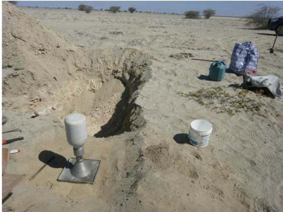
Foto N° 29: Vista de la ejecución del ensayo de densidad de campo, realizado a diferentes profundidades en la calicata C-7.
