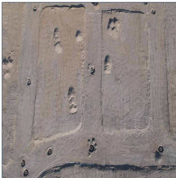
Figura N° 6.8 Vista del terreno natural con buzones excavados.
