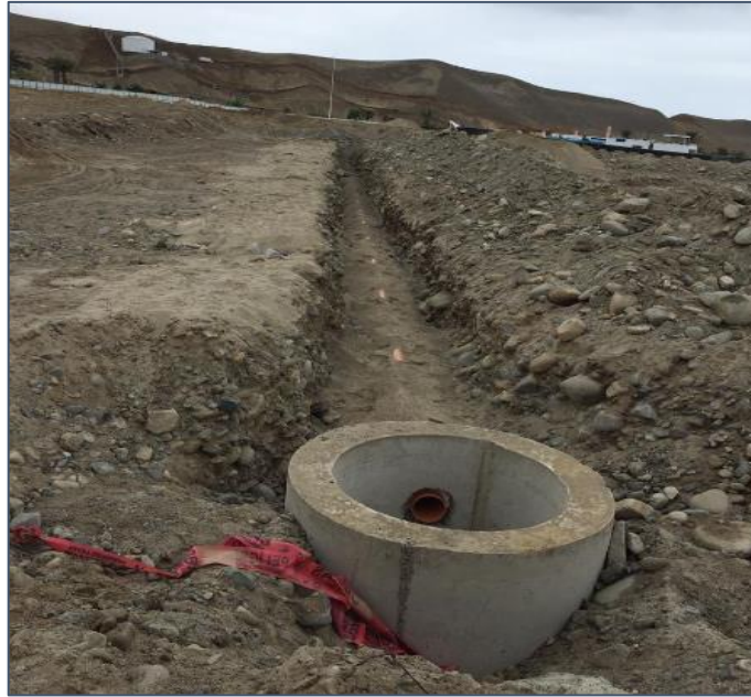
Figura N° 6.11. Vista del cuerpo de buzón y tubería de alcantarillado entre buzones.
