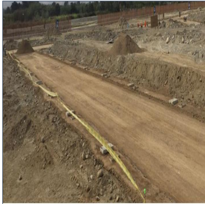
Figura N° 6.16. Afirmado colocado en vía, bermas y veredas.
