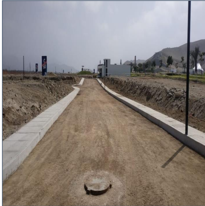
Figura N° 6.20. Calle con afirmado culminado, previo a asfalto.
