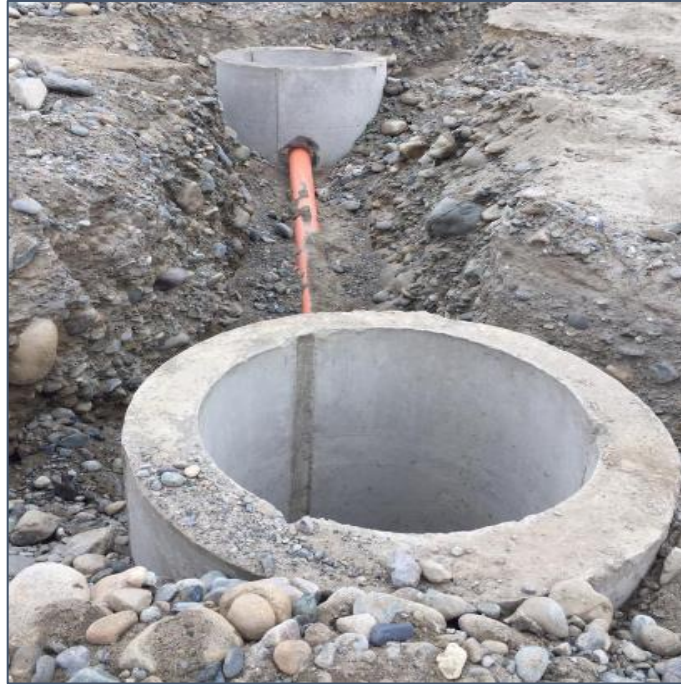
Figura N° 6.10: Vista del cuerpo de buzón y tubería de alcantarillado entre buzones.
