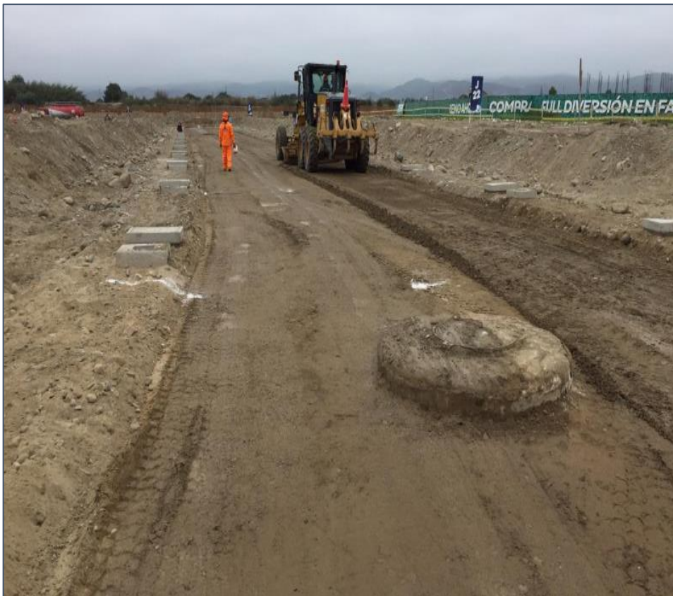
Figura N° 6.18 Vista del escarificado ejecutado por la motoniveladora.
