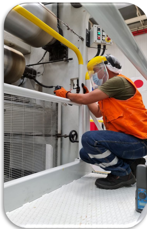
Fig. 3.4: Fotografía de la instalación del acelerómetro en la banda transportadora
