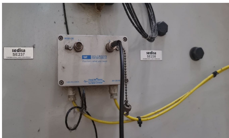
Fig. 3.1: Fotografía de la instalación de los sensores de vibración.
