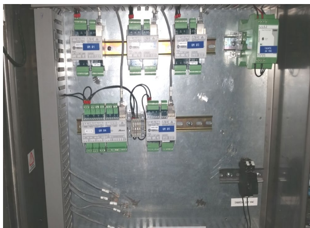
Fig. 3.5: Fotografía de la instalación del Vibraspec 800 en el tablero de control.
