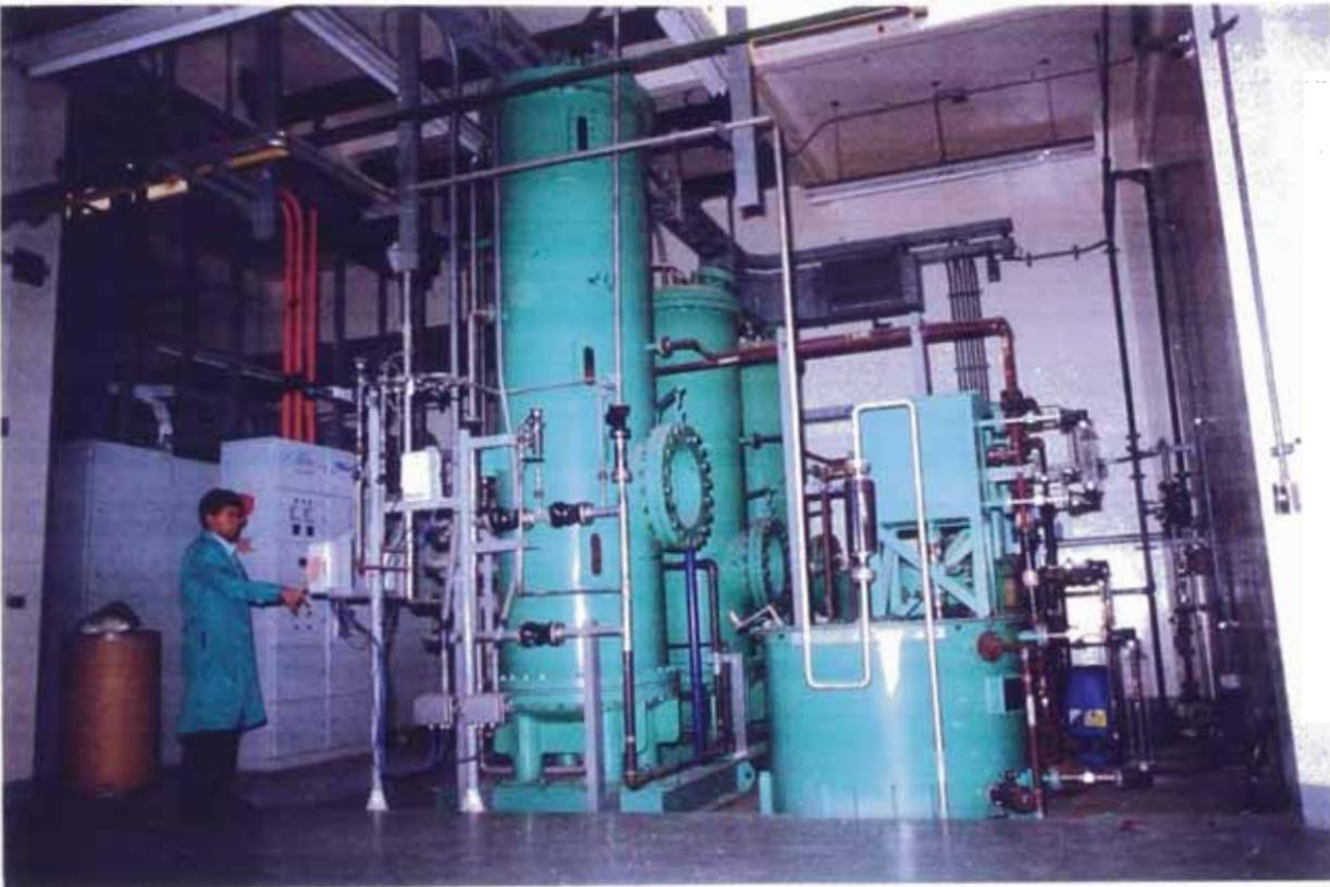
Foto No. 06 Planta de desmineralización de agua por intercambio iónico.
