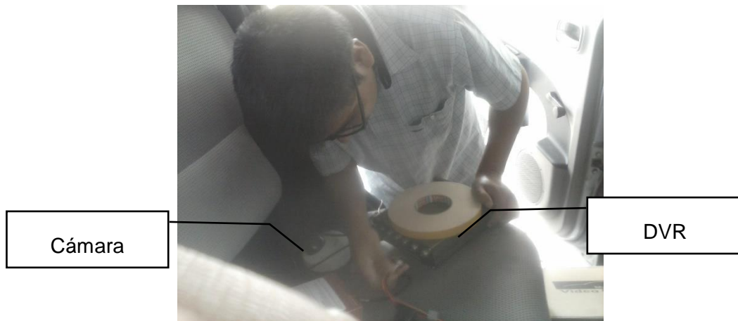
Figura 29 Instalación del equipo
