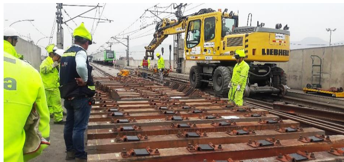
Fig. N° 2.32 Reparto de durmientes en premontaje Cola de Vía Bayóvar Fuente: Elaboración propia
