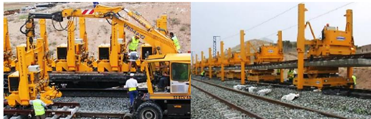
Fig. N° 3.13 Instalación de un cambiavía con sistema PEM-LEM
