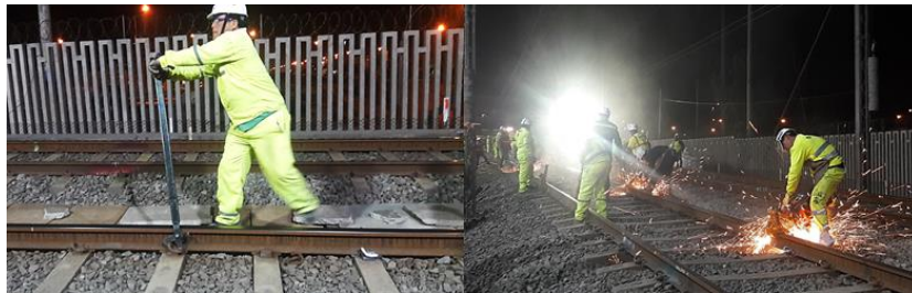
Fig. N° 2.62 Corte de parejas de vía en alto impacto
