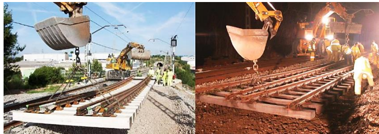
Fig. N° 3.3 Instalación de cambiavías nuevos en segmentos por excavadoras biviales Fuente: (MAINLINE Consortium, 2014, p. 17)
