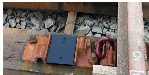
Fig. N° 2.9 Placas de asiento de durmientes de madera de la Línea 1 del Metro de Lima Fuente: Elaboración propia
