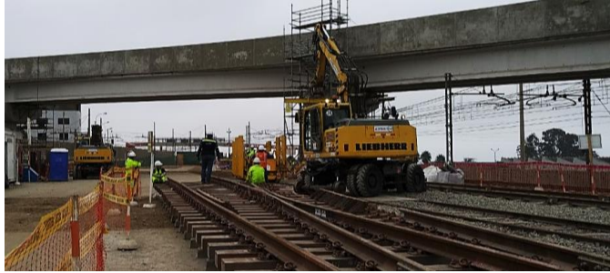
Fig. N° 2.39 Descarga de paquetes de durmientes en premontaje VES Fuente: Elaboración propia
