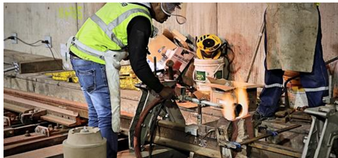
Fig. N° 2.57 Precalentamiento para soldadura aluminotérmica
