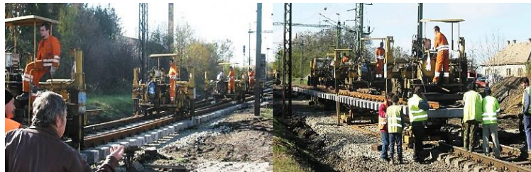
Fig. N° 3.8 Reemplazo de un cambiavía utilizando el sistema Geismar UWG Fuente: (MAINLINE Consortium, 2014, p. 22)
