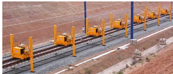
Fig. N° 3.5 Instalación de un panel de cambiavías por grúas pórtico Fuente: (MAINLINE Consortium, 2014, p. 19)
