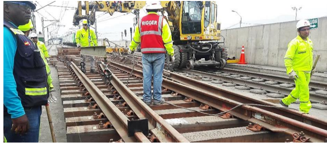
Fig. N° 2.33 Montaje de rieles en premontaje Cola de Vía Bayóvar Fuente: Elaboración propia
