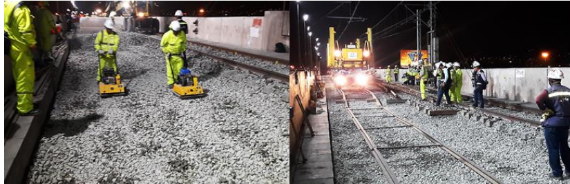
Fig. N° 2.65 Colocación de vía provisional en alto impacto
