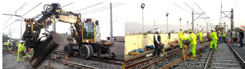
Fig. N° 2.67 Regado de balasto en alto impacto
