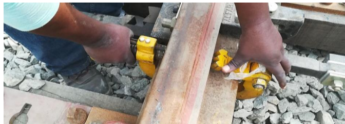
Fig. N° 2.34 Embrizado de juntas en premontaje Cola de Vía Bayóvar Fuente: Elaboración propia
