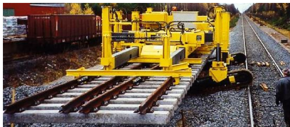
Fig. N° 3.11 Transporte de un cambiavía mediante viga-grúa
