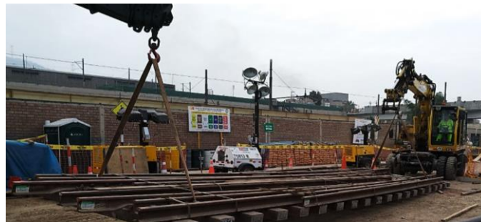
Fig. N° 2.38 Descarga del cuerpo de agujas en premontaje VES
