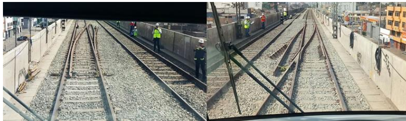
Fig. N° 2.71 Prueba de trenes en alto impacto
