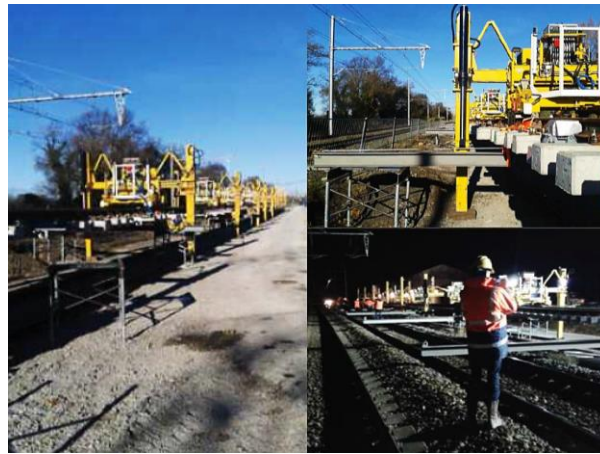
Fig. N° 3.15 Montaje de cambiavías en LGV Nimes-Montpellier (CNM) Fuente: (Colas Rail, 2017)
