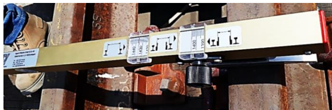
Fig. N° 2.35 Verificaciones geométricas en premontaje Cola de Vía Bayóvar Fuente: Elaboración propia
