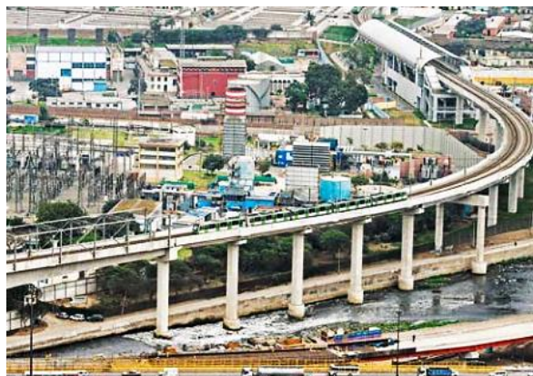
Fig. N° 4.3 Viaducto elevado de la Línea 1 del Metro de Lima
