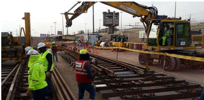
Fig. N° 2.40 Montaje de rieles en premontaje VES Fuente: Elaboración propia
