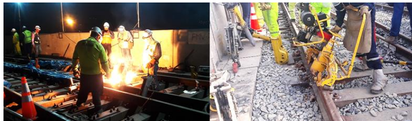
Fig. N° 2.68 Soldaduras aluminotérmicas en alto impacto
