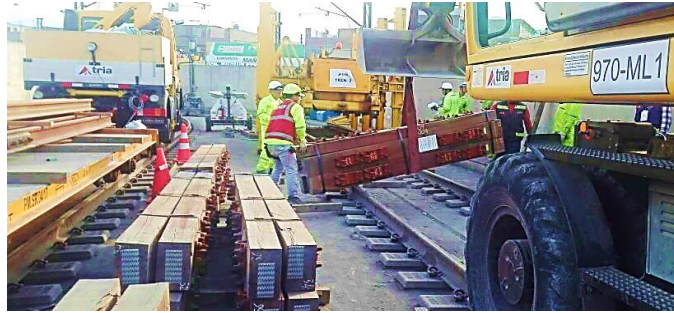
Fig. N° 2.31 Descarga de paquetes de durmientes en premontaje Cola de Vía Bayóvar Fuente: Elaboración propia
