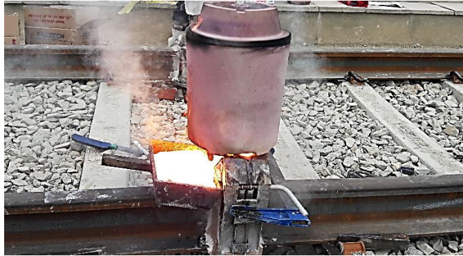
Fig. N° 2.58 Colada del material aluminotérmica
