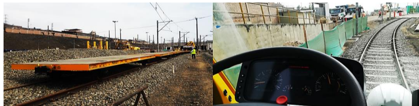
Fig. N° 2.51 Prueba dinámica 1 en la Zona 56 del Patio VES
