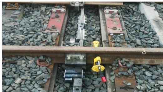
Fig. N° 2.70 Consolidación de vía mediante sargento en alto impacto Fuente: Elaboración propia
