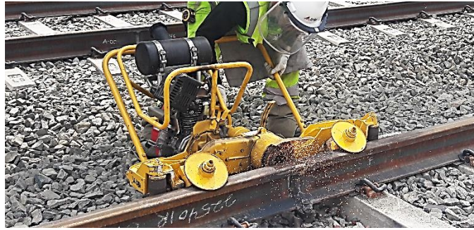
Fig. N° 2.59 Esmerilado de soldadura aluminotérmica
