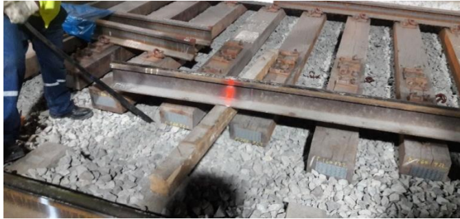
Fig. N° 2.48 Marcaje de punto de corte para sustitución de cupones
