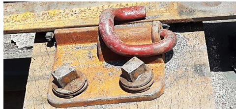
Fig. N° 2.8 Sistema de sujeción de durmientes de madera de la Línea 1 del Metro de Lima Fuente: Elaboración propia
