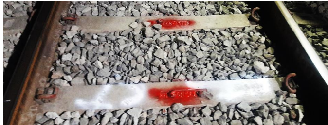
Fig. N° 2.50 Marcaje de durmientes 58 y 59 para alto impacto
