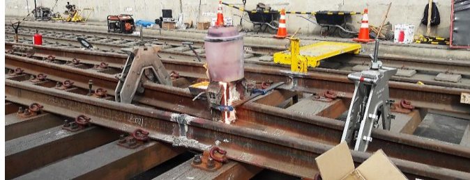
Fig. N° 2.36 Soldaduras aluminotérmicas en premontaje Cola de Vía Bayóvar Fuente: Elaboración propia
