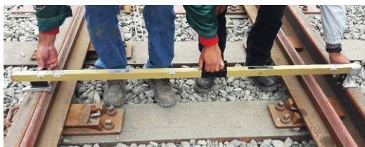
Fig. N° 2.69 Verificación de trocha y peralte en alto impacto
