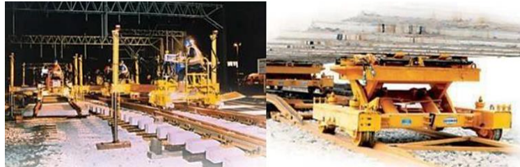
Fig. N° 3.12 Gatos PUM y carros MWT durante renovación de cambiovía
