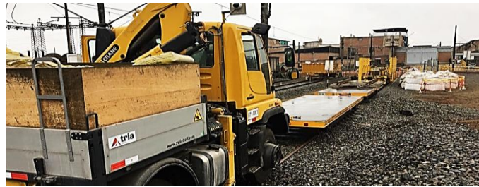
Fig. N° 2.42 Carguío del TT3 para premontaje en Tercera vía de Av. México Fuente: Elaboración propia
