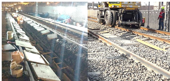
Fig. N° 4.5 Zona de canaleta central antes y durante la jornada de alto impacto
