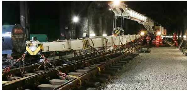
Fig. N° 3.6 Instalación de un cambiavía utilizando la grúa Kirov
