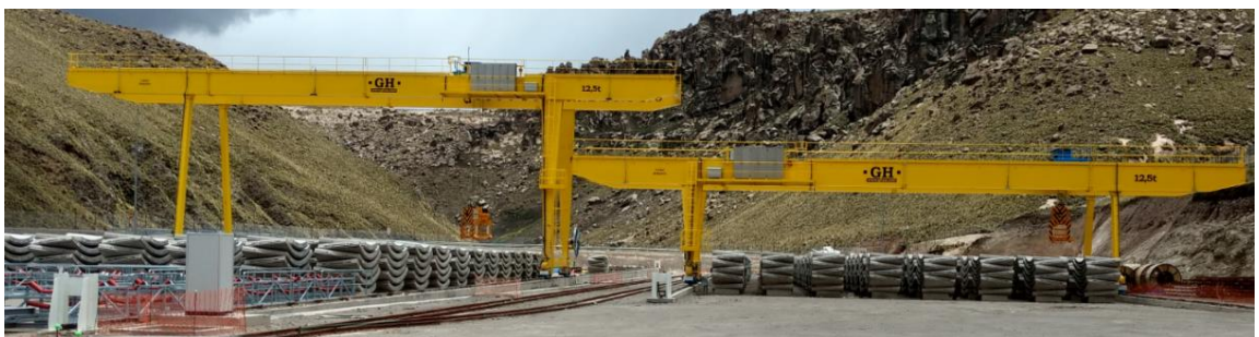
Figura 4.25: Zona de acopio de dovelas y grúas pórtico (Fuente: Registro fotográfico de obra)
