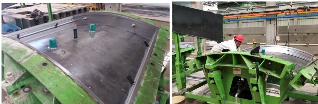
Figura 4.16: Colocación de insertos para pernos y limpieza de moldes (Fuente: Registro fotográfico de obra)
