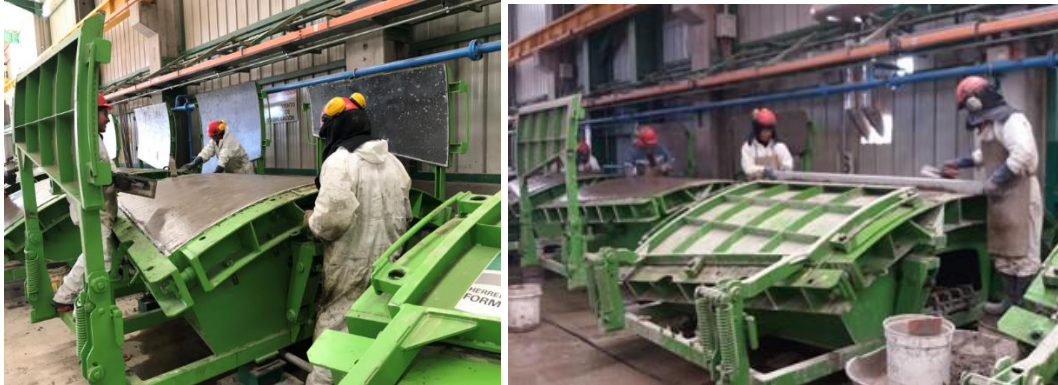
Figura 4.18: Acabado manual de cara exterior de dovela (Fuente: Registro fotográfico de obra)
