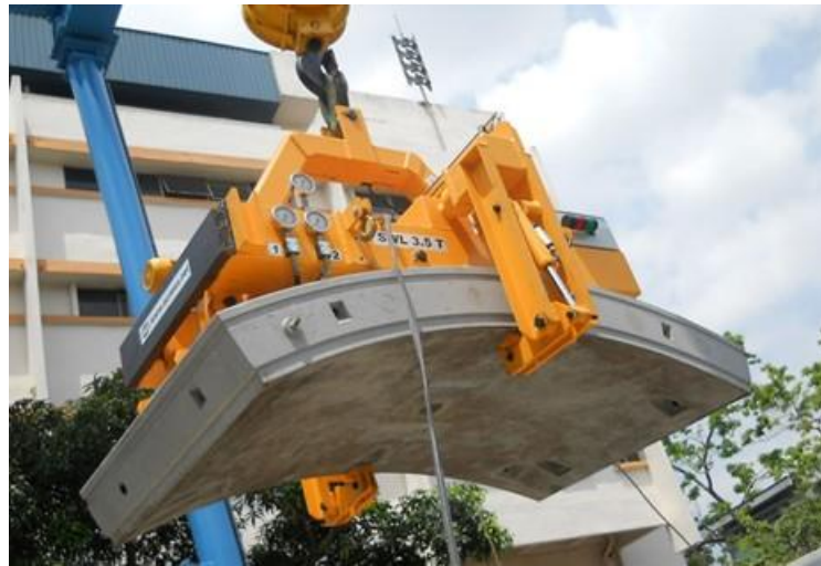
Figura 2.18: Pinzas para manipulación de dovelas (Fuente: acimex.net)
