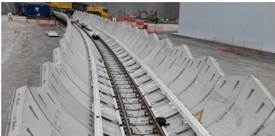
Figura 4.28: Cuna del back up, conformada por pares de dovelas estándar, rieles para tren de producción y rieles para remolques (Fuente: Registro fotográfico de obra)
