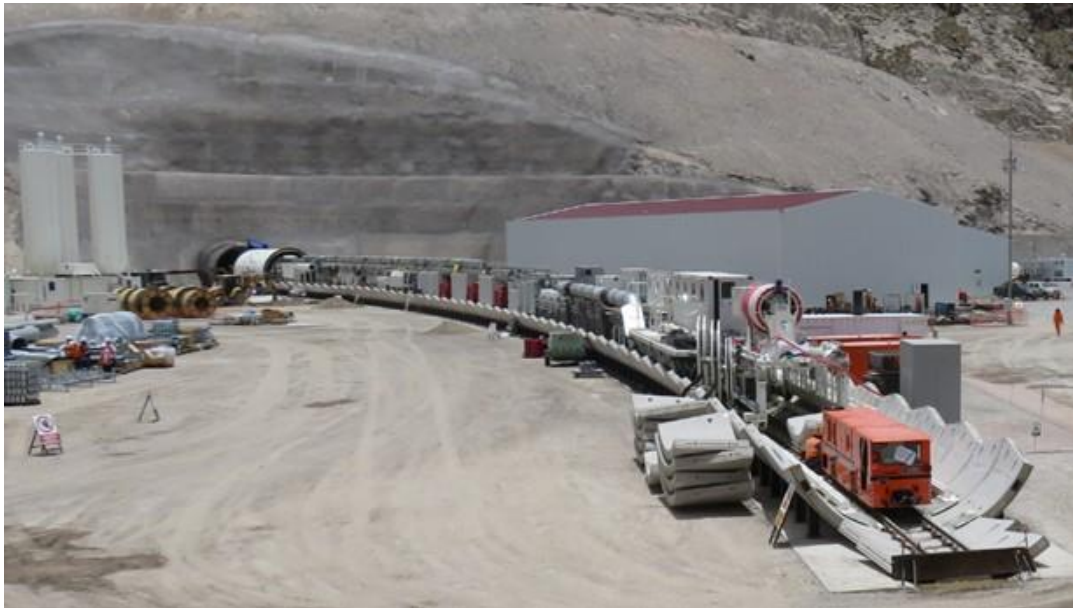
Figura 4.33: Montaje finalizado de la TBM hasta el remolque 13
