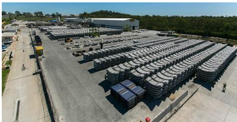
Figura 2.16: Planta de prefabricado de dovelas y acopio de anillos (Fuente: wagner.com.au)
