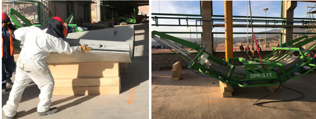
Figura 4.22: Pegado manual y prensado mediante cuadro de pegado (Fuente: Registro fotográfico de obra)
