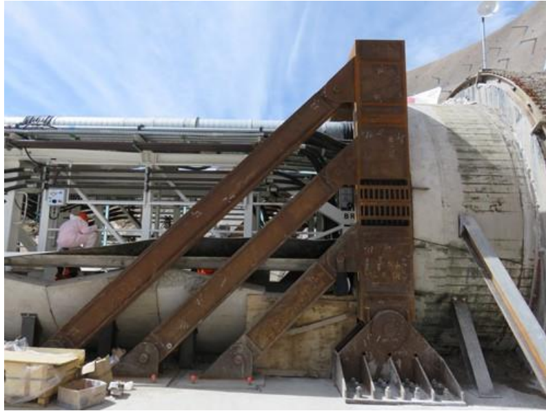
Figura 4.38: Estructura de reacción, anillo cero con puntales metálicos y relleno de bicomponente colocado (Fuente: Registro fotográfico de obra)
