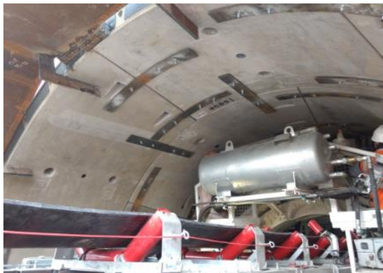
Figura 4.39: Vista interior de dovelas de anillo cero sujetadas por escuadras metálicas y por placas en conjunto con anillo uno (Fuente: Registro fotográfico de obra)
