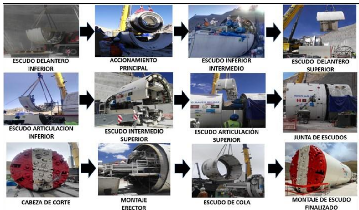
Figura 4.31: Desarrollo del montaje de escudos de la TBM (Fuente: Registro fotográfico de obra)
