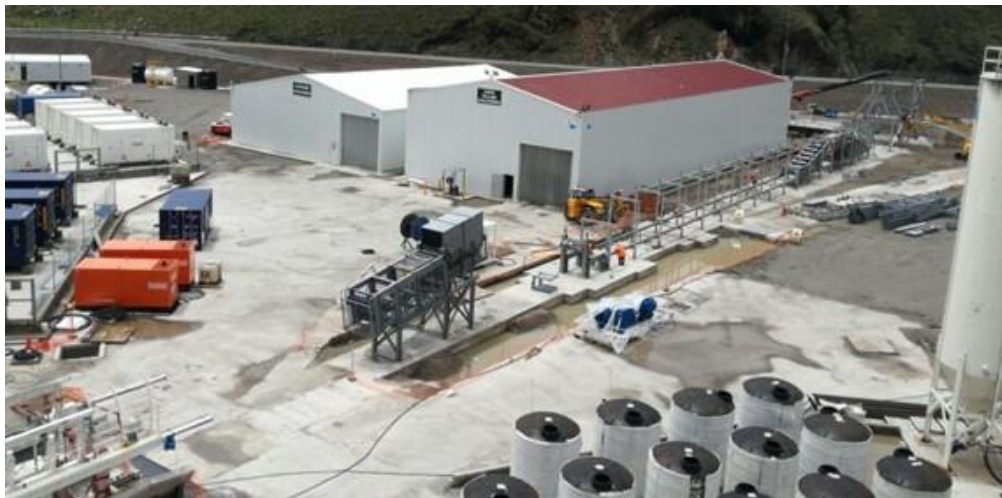
Figura 4.40: Montaje de enrollador de banda como parte de la estructura de cinta exterior (Fuente: Registro fotográfico de obra)
