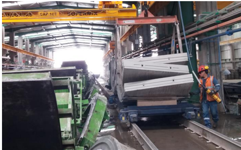
Figura 4.21: Transporte de 3 dovelas sobre carro trolley (Fuente: Registro fotográfico de obra)
