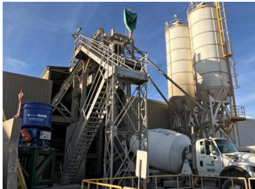
Figura 4.14: Planta de concreto para dovelas (Fuente: Registro fotográfico de obra)
