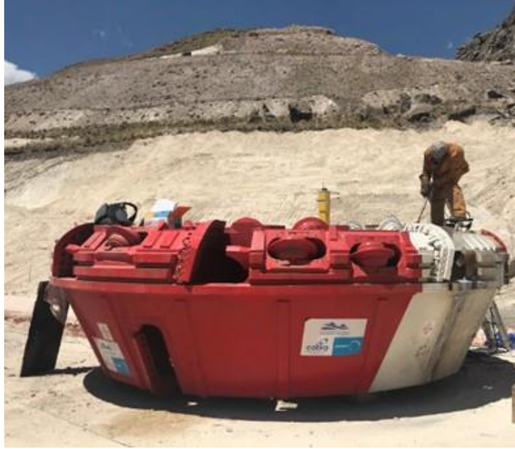
Figura 4.30: Soldadura de cabeza de corte (Fuente: Registro fotográfico de obra)
