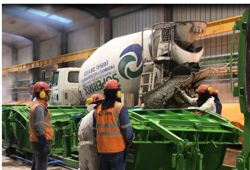
Figura 4.17: Colocación de concreto en molde de dovela (Fuente: Registro fotográfico de obra)
