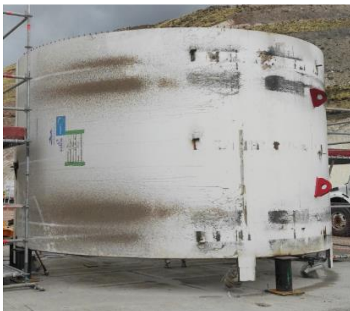
Figura 4.29: Escudo de cola posicionado para soldadura (Fuente: Registro fotográfico de obra)
