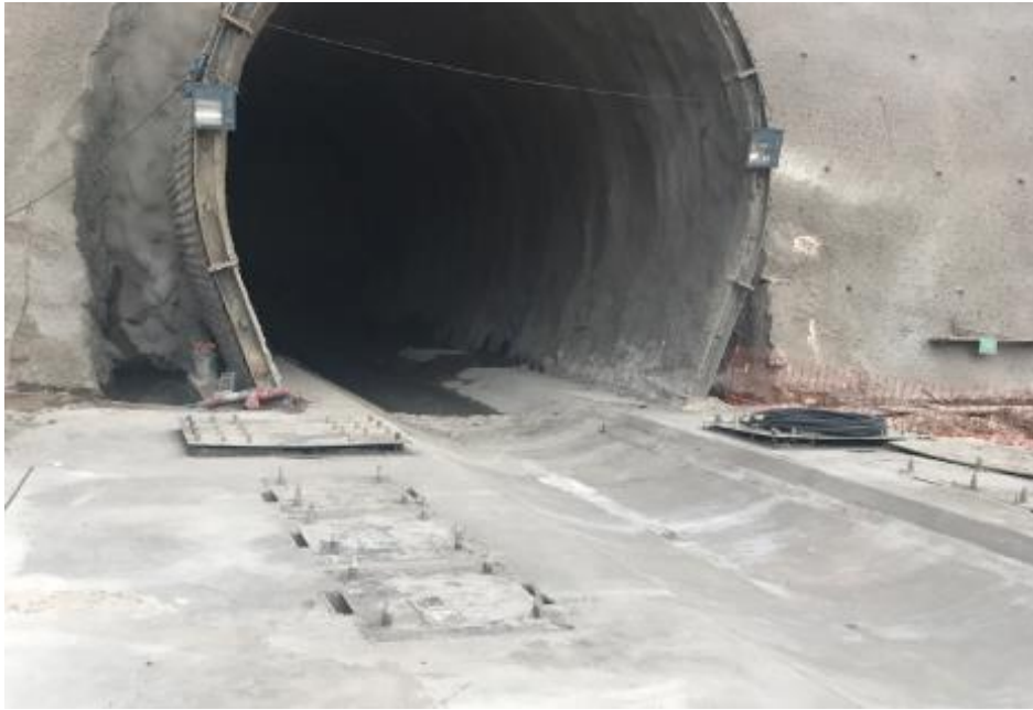
Figura 4.27: Cuna de apoyo de TBM y pedestales de estructura de reacción (Fuente: Registro fotográfico de obra)
