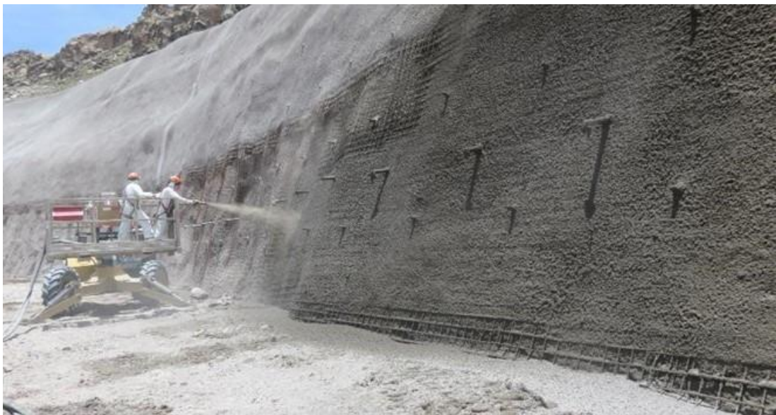
Figura 4.9: Colocación de segunda capa de shotcrete (Fuente: Registro fotográfico de obra)
