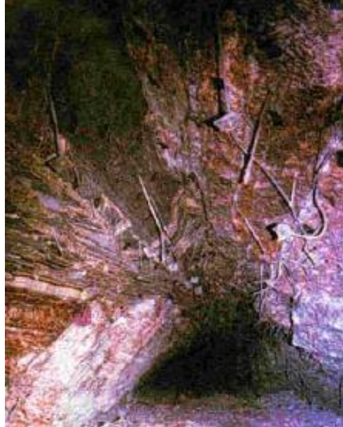
Figura 2.8: Grandes deformaciones (squeezing) de lutitas y sales con rotura de pernos (Fuente: González de Vallejo, 2002)
