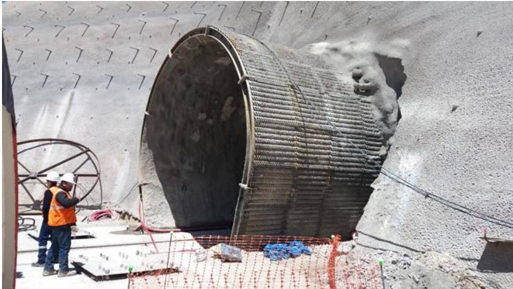
Figura 4.11: Visera de protección y viga de atado con micropilotes finalizada (Fuente: Registro fotográfico de obra)
