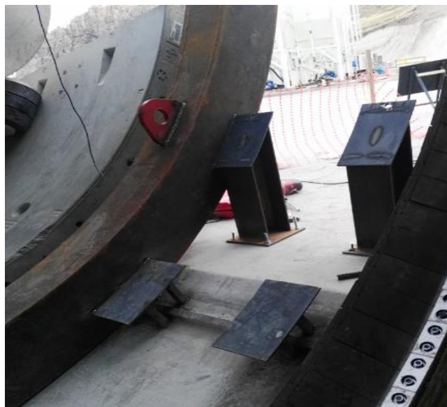
Figura 4.35: Arco metálico y apoyos metálicos para colocación de dovelas (Fuente: Registro fotográfico de obra)
