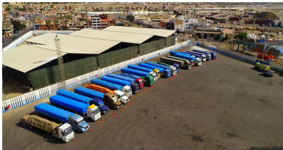
Figura N°3.24 Situación de la zona de almacenamiento – Zona N°4 Fuente: ENAPU S.A
