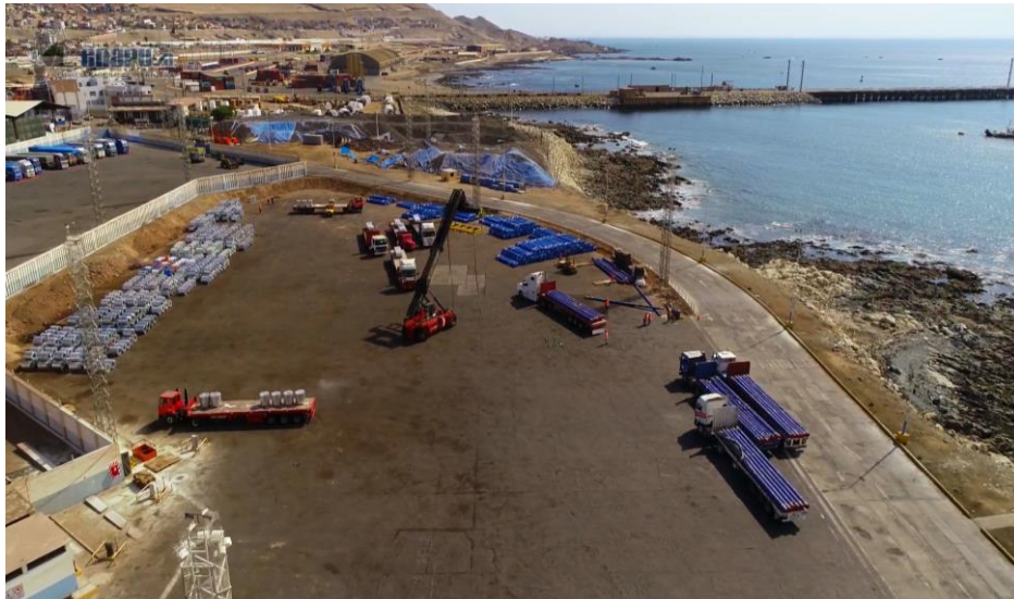
Figura N°3.23 Situación de la zona de almacenamiento – Zona N°3 Fuente: ENAPU S.A.
