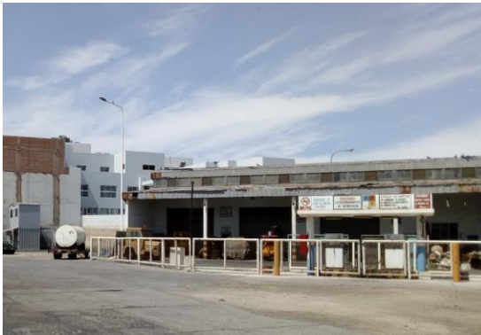
Taller de mantenimiento al costado de la zona N°6
