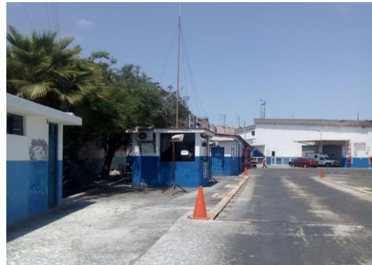
Caseta de control, brigada de emergencias y servicios
