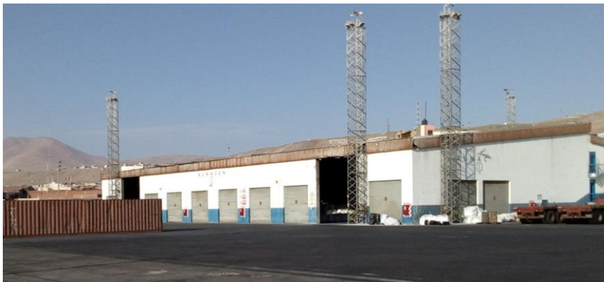
Almacén techado ubicado en la zona N°2
