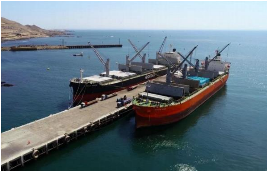
Figura N°3.5 Utilización de los amarraderos Fuente: ENAPU S.A.
