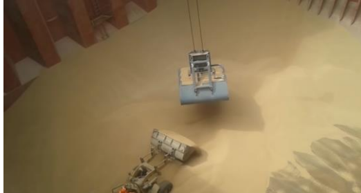
Carga del Clamshell con grúa en la nave
