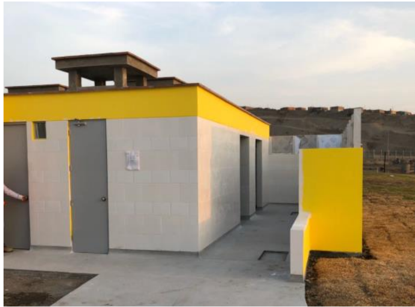
Imagen A1-8: Vista del sector B10 en acabados.
