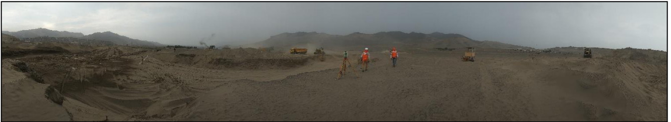
Figura 4-4 : Imagen representativa de Trabajos del mes 1.
