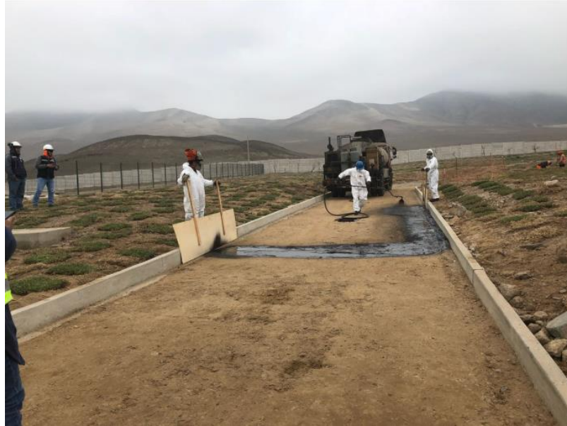
Imagen A1-10: Trabajos de asfalto en senderos del parque.
