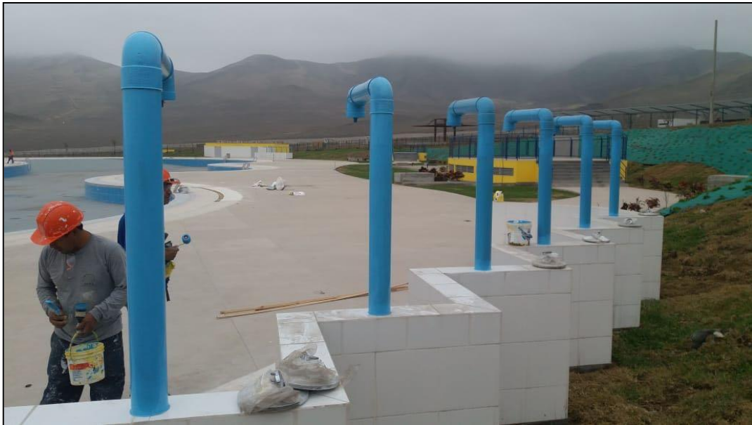
Figura 4-14 : Imagen representativa de Trabajos del mes 6.
