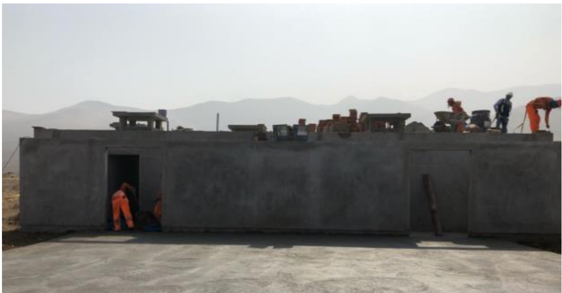
Imagen A1-5: Trabajos en fachada en el sector B5.
