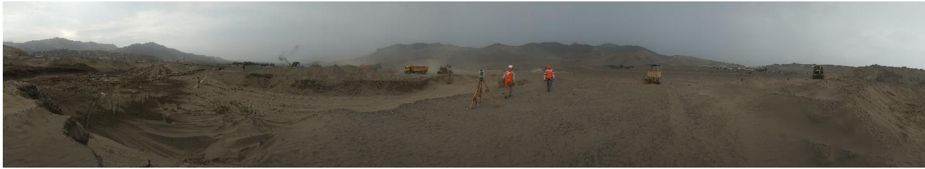
Imagen A1-3: Trabajos de Movimiento de tierras al inicio de obras.
