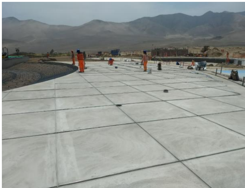
Imagen A1-7: Losas de piso alrededor de las piscinas.
