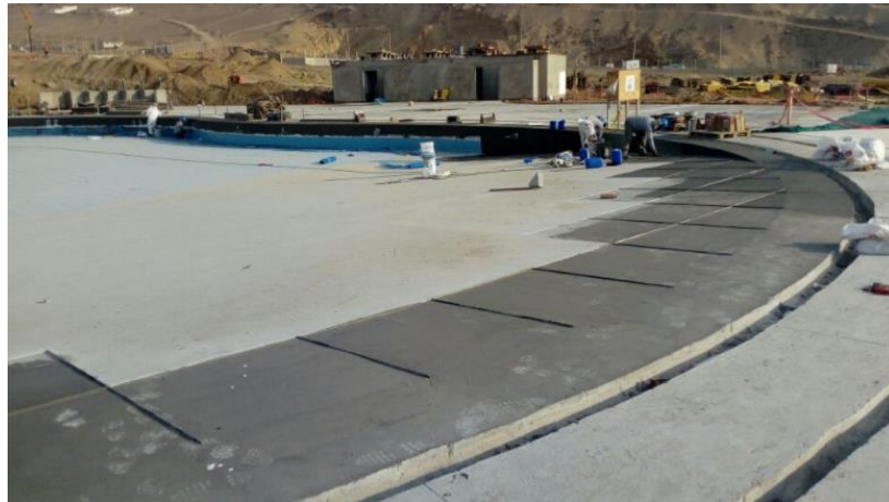
Imagen A1-6: Impermeabilización y acabados en piscina B9.
