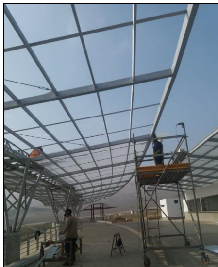
Figura 4-10 : Imagen representativa de Trabajos del mes 4.
