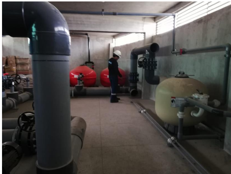
Figura 4-12 : Imagen representativa de Trabajos del mes 7.
