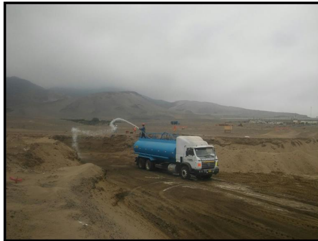
Figura 4-6 : Imagen representativa de Trabajos del mes 2.
