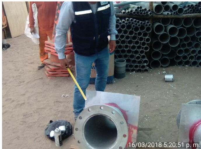
Imagen A1-4: Prueba de líquido penetrante en Bridas.
