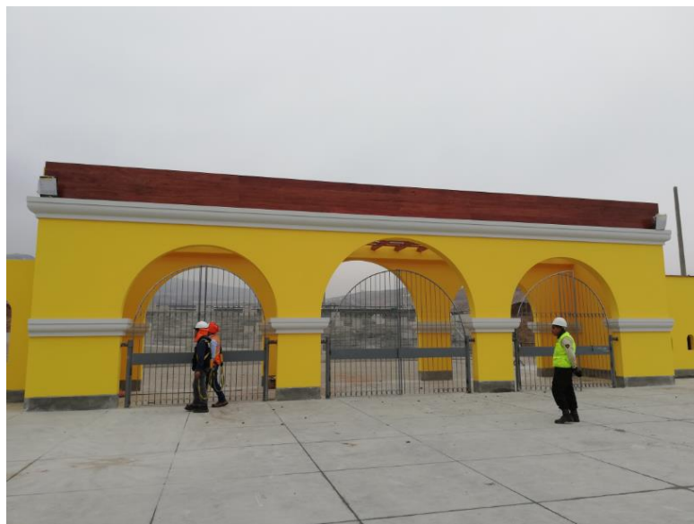
Imagen A1-9: Vista del Ingreso principal con los acabados.
