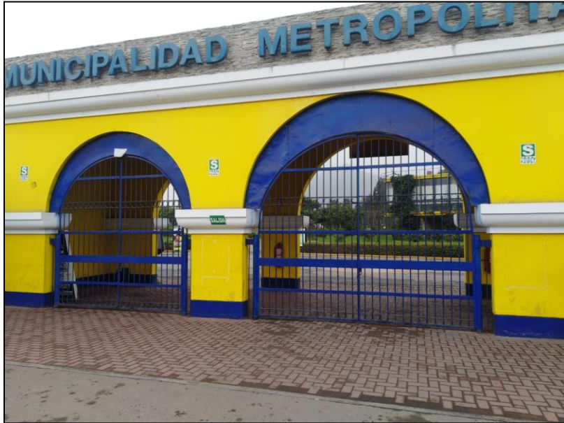
Figura 4-16 : Imagen representativa de Trabajos del mes 7.
