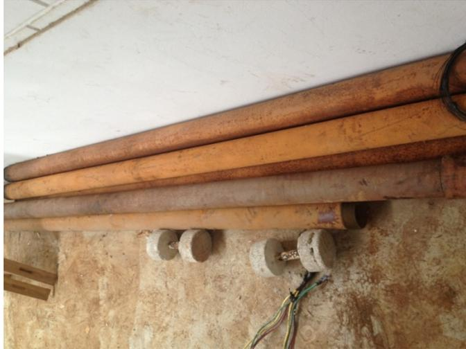
FOTO N°02: En la foto se observa la oxidación de las tuberías de descarga de 110 mm de acero de SCH 40, estas tuberías tienen solo un mes de instalación, sin embargo la corrosión de las tuberías es evidente.
