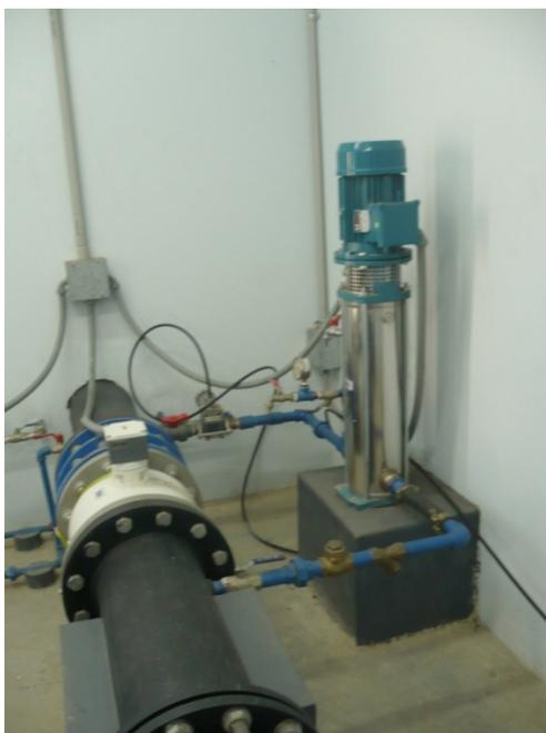
FOTO N° 34: Electroboomba booster de alta presión.
