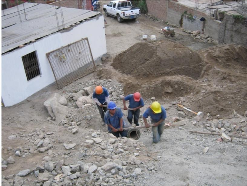
FOTO N° 05: Se observa el acarreo de un niple de 200 mm ya que no se tiene vías de acceso por lo cual se debe considerar en el presupuesto el acarreo de los materiales.
