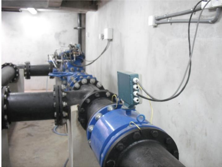
FOTO N°28: Display de medidor de caudal invertida
