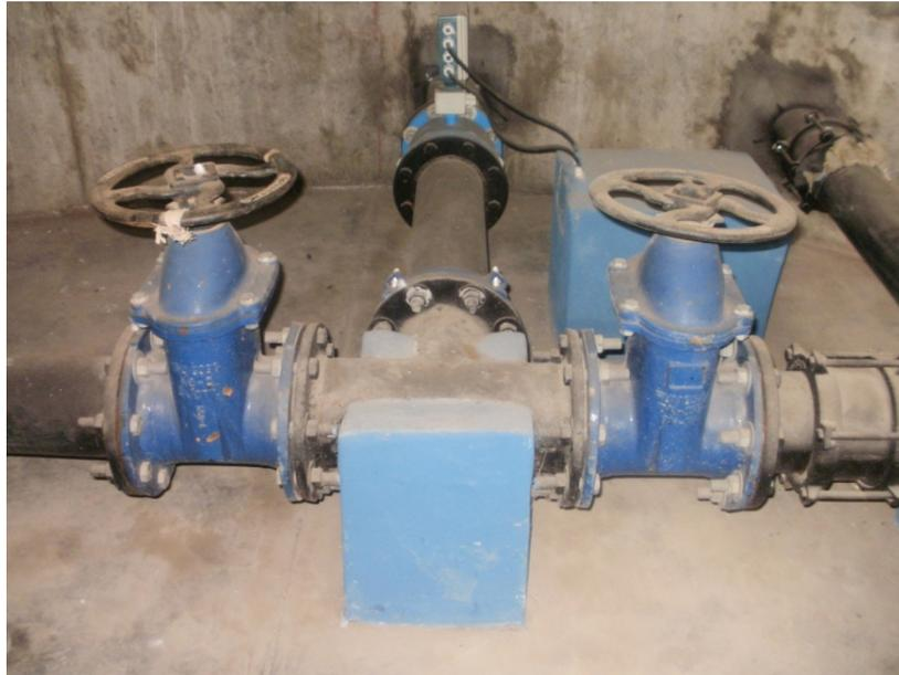
FOTO N° 13: En la foto se observa que la TEE BBB no está fijada en un dado de apoyo si no en un dado de anclaje, para algún trabajo eventual de mantenimiento se tendría que romper el dado de anclaje.
