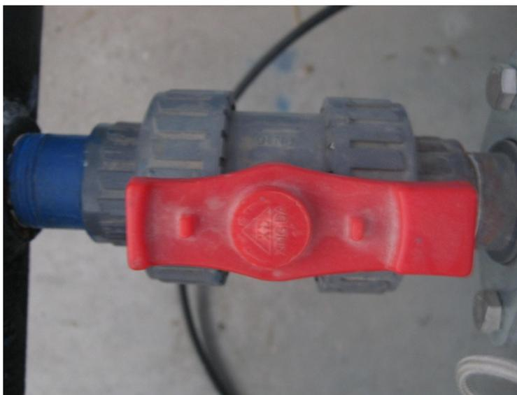
FOTO N° 36: Válvula de bola gris para gran presión y soporte al ataque químico
