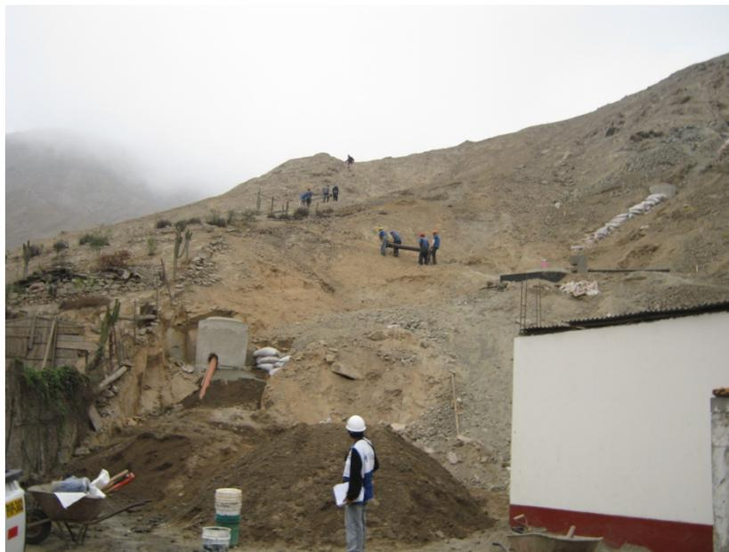
FOTO N° 06: Vista del acarreo de niples de 200 mm ya habilitados hacia el reservorio RP-03 Cieneguilla
