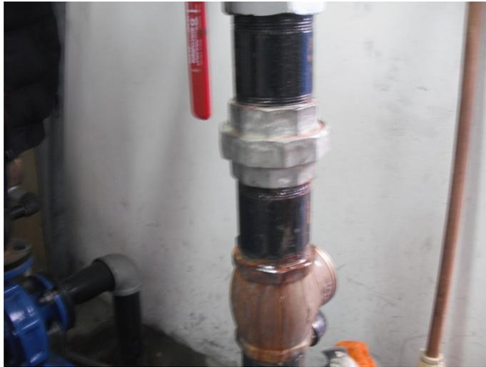
FOTO N°22: La utilización de accesorios de unión rosca no es recomendable ya que realizada la evaluación se han observado fugas, sin embargo en las uniones bridadas no se han encontrado este tipo de problemas debido a la utilización de empaquetaduras que nos garantiza un sellado efectivo a las fugas además de tener rapidez en los trabajos de mantenimiento. La utilización de uniones unión rosca es recomendable para
