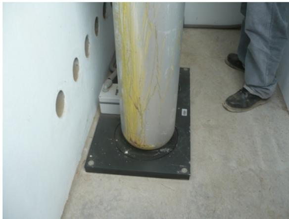
FOTO N° 42: Celda de carga para el peso de balones de cloro.
