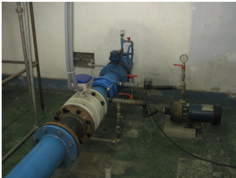
FOTO N° 40: La instalación de la bomba booster centrifuga horizontal en lo óptimo debe ser alineado al punto de inyección, con ello disminuimos la utilización de accesorios para evitar las pérdidas de carga el objetivo es de mantener la presión de salida hacia el inyector para generar el vacío.
