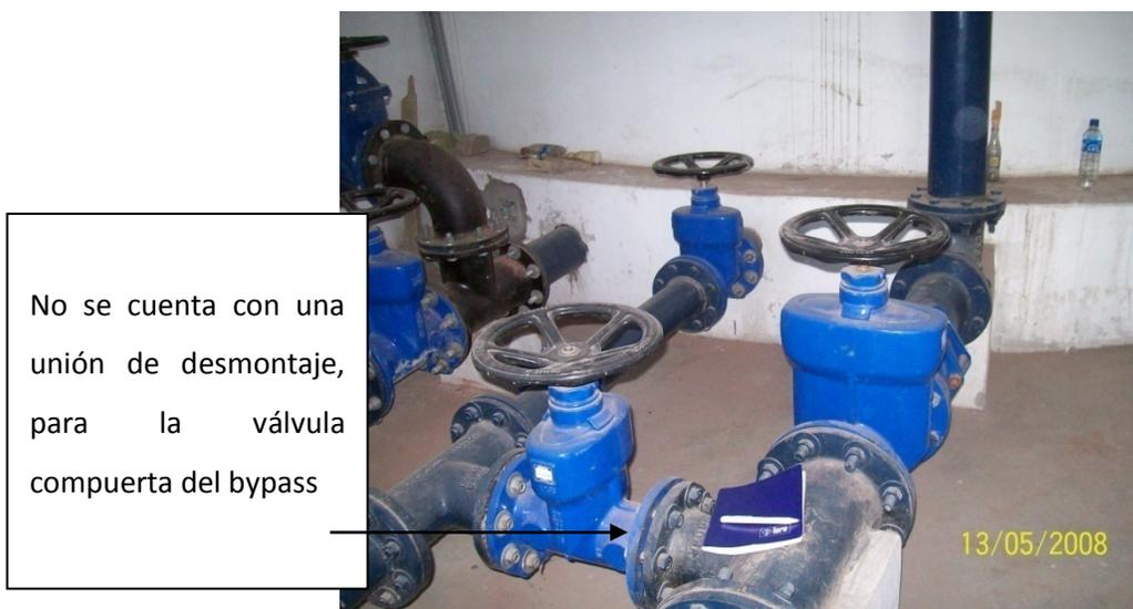
FOTO N° 45: Vista de bypass en el reservorio RP-4C San Juan de Lurigancho
