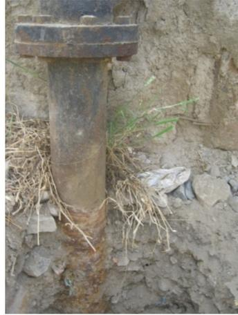
FOTO N° 17 Y N°18: En la foto se puede observar que la tubería no ha sido protegida por lo cual el ataque químico del suelo por oxidación o incrustación en la tubería es evidente.
