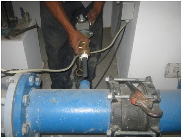
FOTO N° 37: Ensamble conector especial BM-111 armado ya con el difusor e inyector lista para su instalación.
