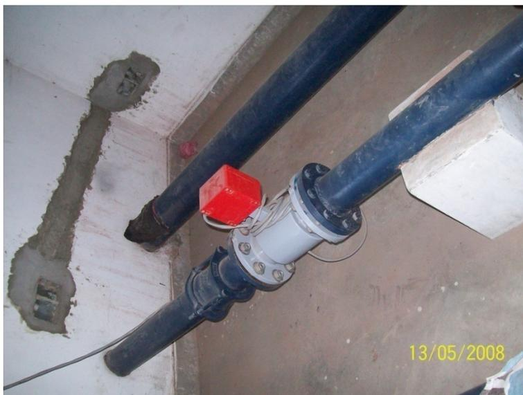
FOTO N° 44: No se cuenta con válvula de aire para la eliminación de aire
