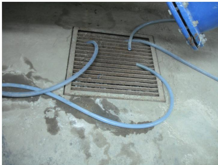
FOTO N°27: Se observa el sumidero de la cámara enterrada, este tipo de sumidero que trabaja como drenaje no podrá evitar una inundación ya que la línea transporta 120 lps, si se hubiese un colapso irrepentino dentro de la cámara se tendría la inundación eminentemente.
