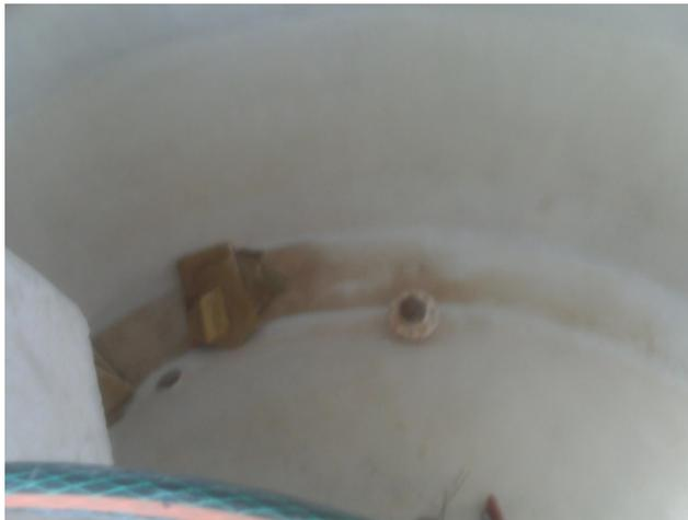
FOTO N°01: En la cuba del reservorio se observa gran sedimentación de óxido dicho problema se encontró al eliminar el agua de la prueba hidráulica, al ubicar el punto de generación de óxido se encontró que era en la línea de impulsión material de acero SCH 40 sin costura, ya que es la
