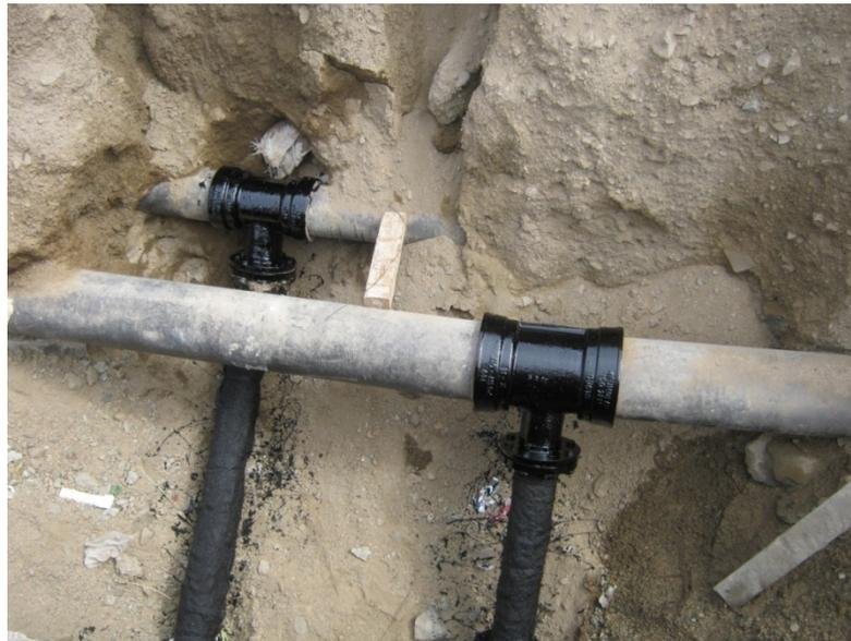
FOTO N°19: Empalmes de cámara de purga al equipamiento de la cámara, se observa que se ha realizado una protección apropiada (yute liquido asfalto y aditivo RC 250).
