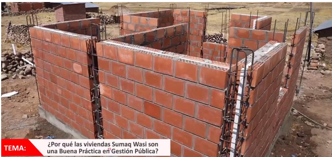
Figura 3. Vivienda Sumaq Wasi elaborada con ladrillo y poliestireno expandido dispuesto en forma de sándwich [26].
