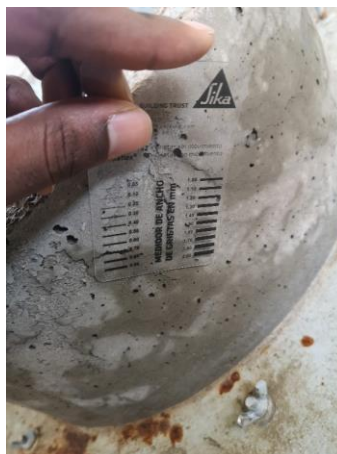
Figura 12 Medición de fisura en anillo de concreto Fuente: Elaboración propia
