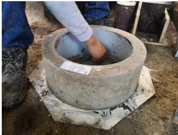
Figura 9 Desencofrado de anillos de concreto Fuente: Propia
