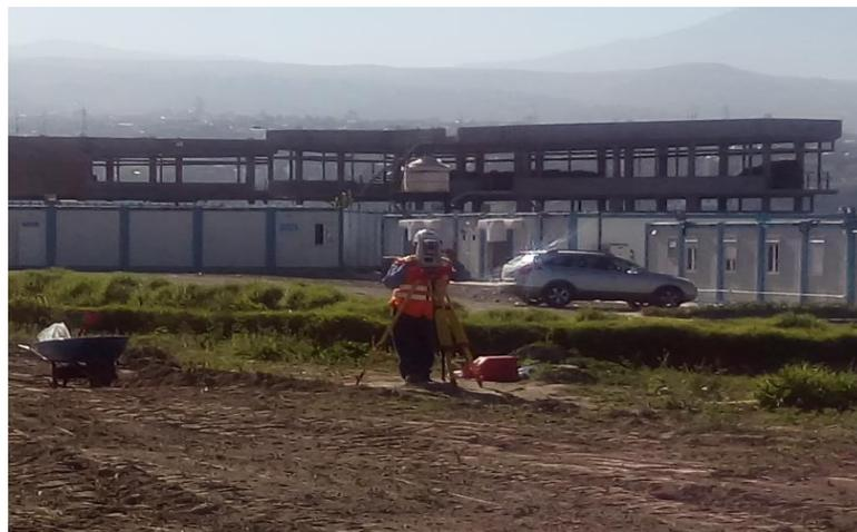
Figura N° 20: Inicio del levantamiento topográfico con Estación Total Leica FlexLine TS06
