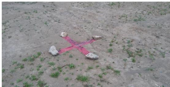
Figura N° 30: Referencia de los puntos de control en campo
