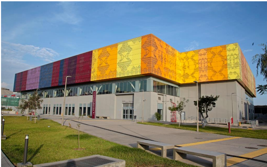
Figura 51: Vista de la Fachada del Polideportivo 03. Fuente: Lima 2019.
