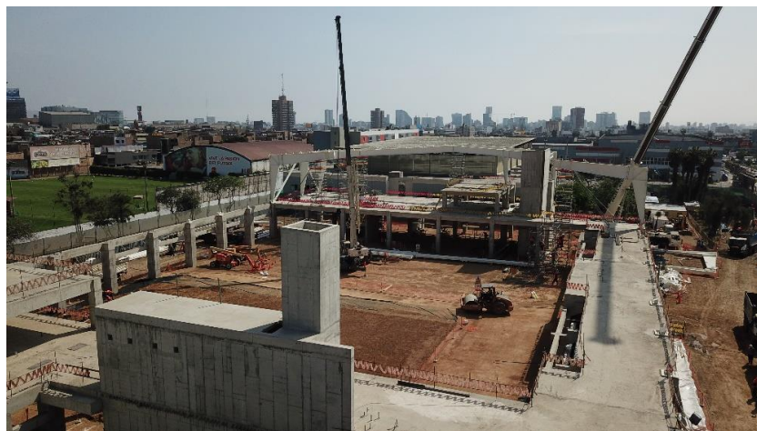
Figura 113: Fotografía del recinto en el mes de octubre. Fuente: COSAPI.
