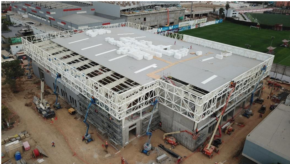
Figura 115: Fotografía del recinto en el mes de diciembre. Fuente: COSAPI.
