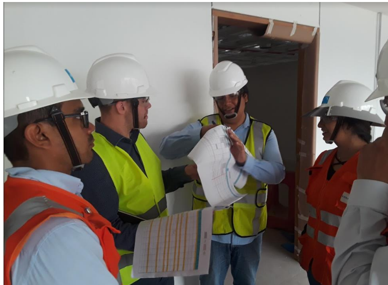
Figura 92. Caminata de obra con el cliente. Fuente: Archivos del autor.
