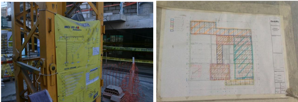
Figura 16: Procedimiento Visual de control de la torre grúa y distribución de las áreas de trabajo. Fuente: Vila (2017).
