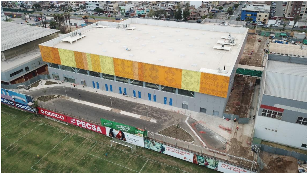
Figura 118: Fotografía del recinto en el mes de marzo. Fuente: COSAPI.
