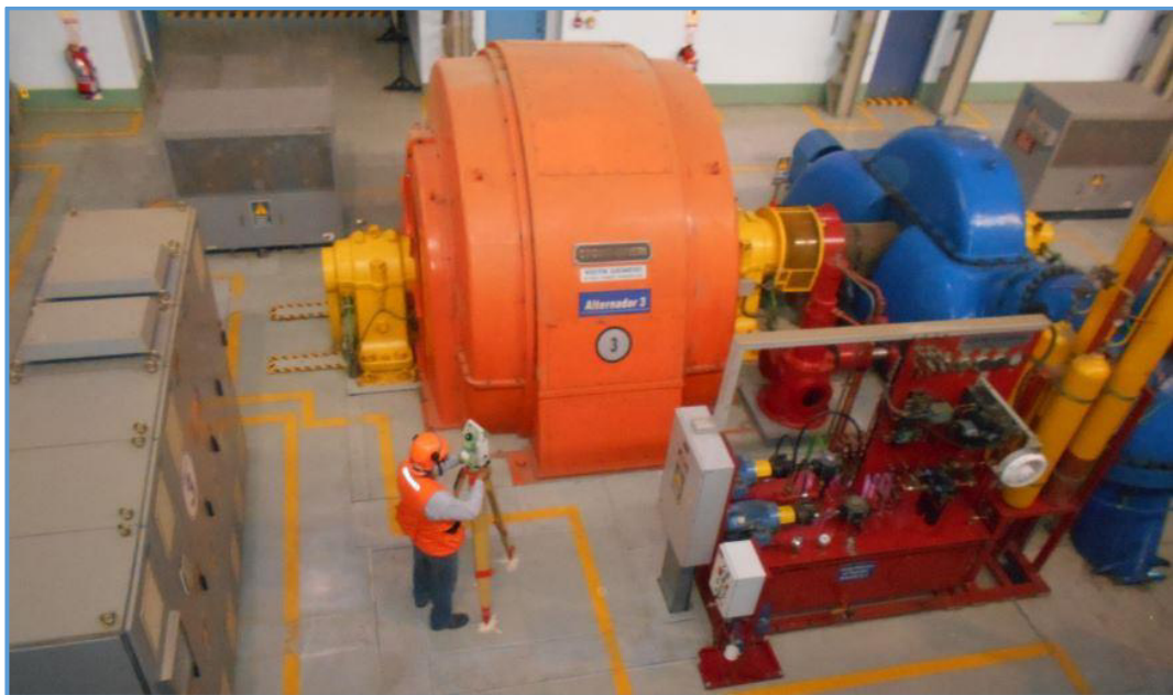
Fig. 3.3. Levantamiento topográfico con estación total en sala de máquinas.
