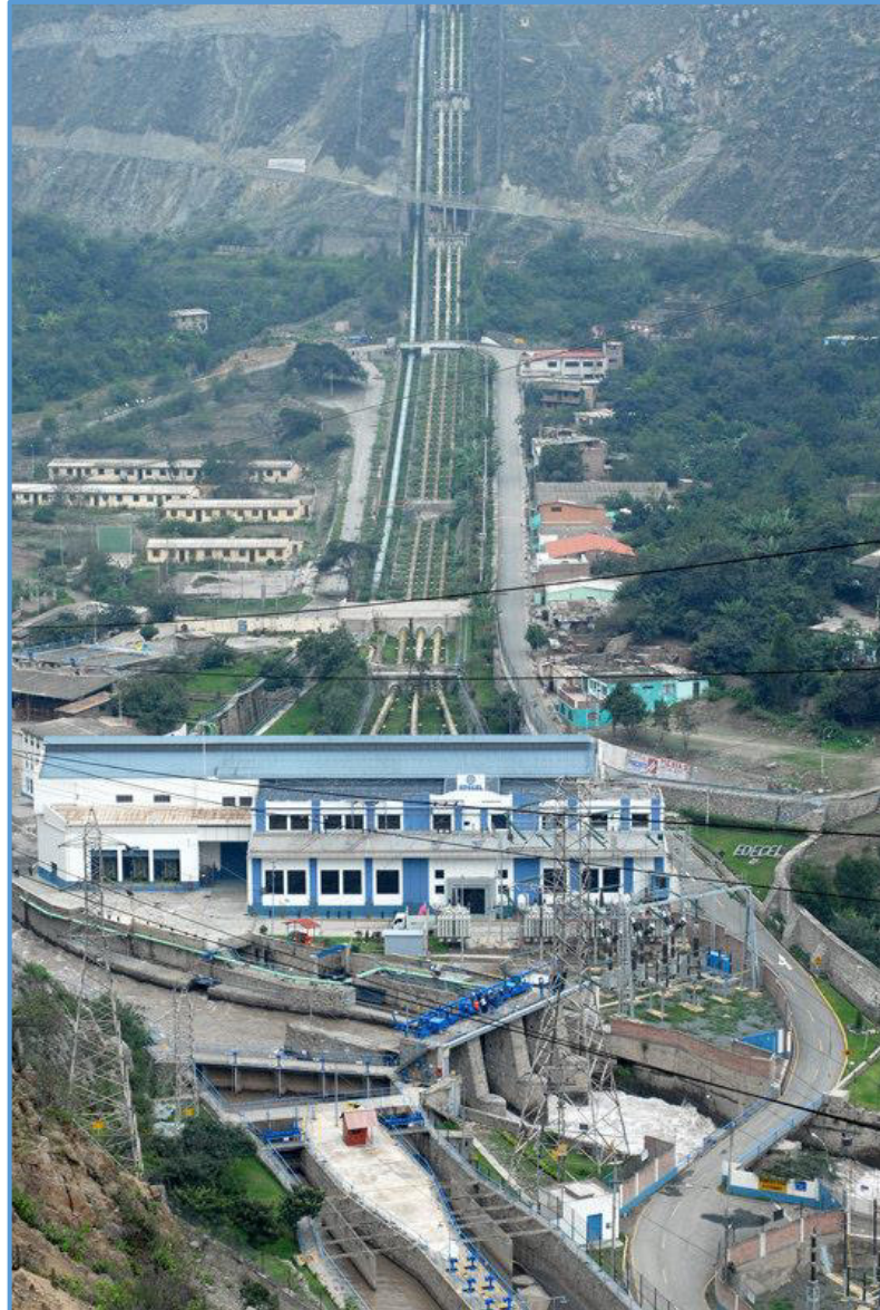
Fig. 2.2. Vista panorámica de la C. H. Callahuanca.
