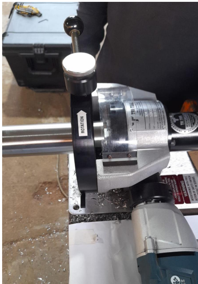
Figura 34. Corte de tubería para obtención de bordes rectos.
