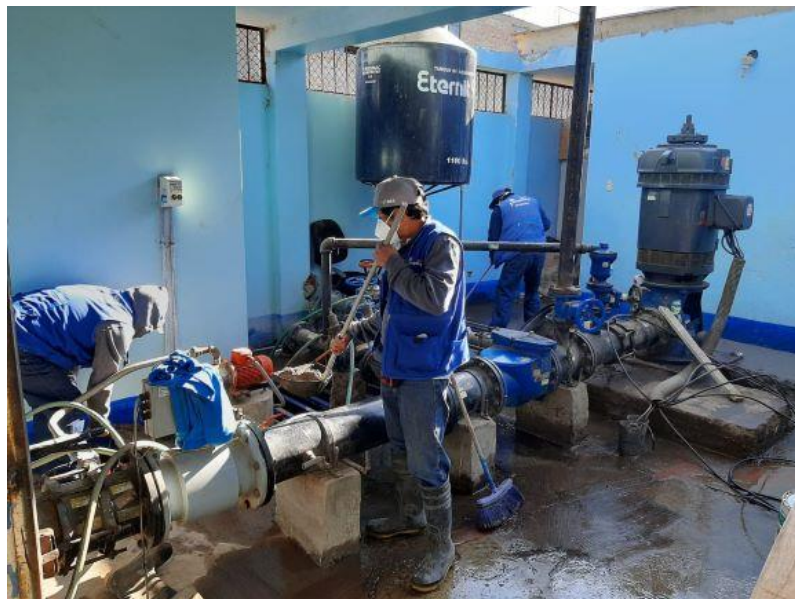
Figura 5.2 Verificación visual de estado de árbol hidráulico en estación de bombeo.
