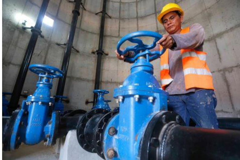
Figura 5.1 Apertura manual de válvula compuerta.
