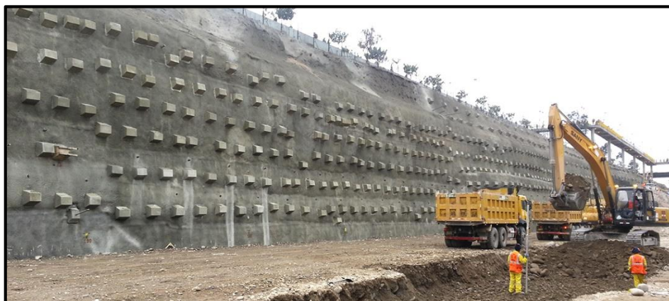
Fig. 3.1. Utilización de anclajes Soil Nailing en el Proyecto Línea Amarilla – Lima – Perú
