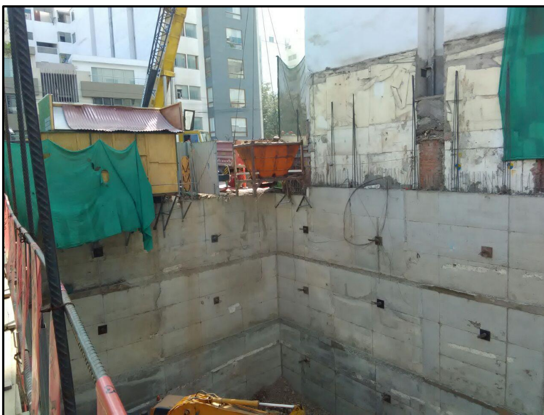
Fig. 3.8. Muros anclados en excavaciones profundas (Obra: Residencial Park Tower – Surquillo, Lima)
