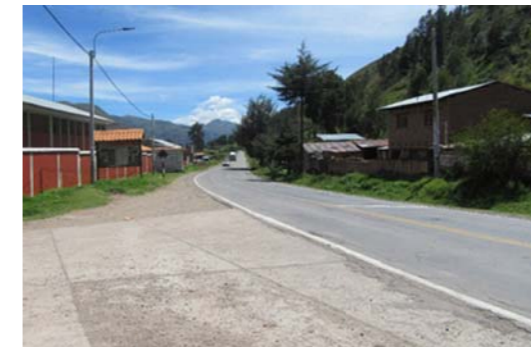
CARRETERA NACIONAL CUSCO - AREQUIPA
