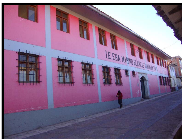
Figura N°A6. 22 Institución Educativa Marino Blancas Tumialan del distrito de Tinta, 2019.
