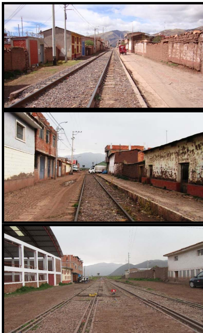
Figura N°A6. 12 Ferrocarril que pasa por la calle José Carlos Mariátegui en el pueblo de Tinta, 2019.
