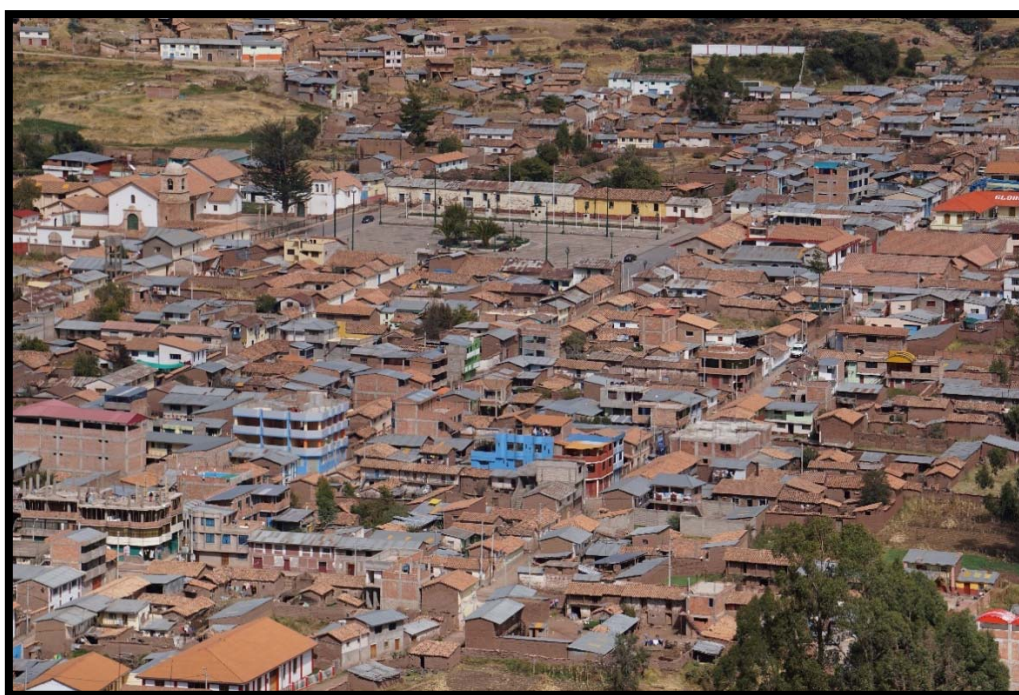
Figura N°A7. 1 Tipo de viviendas predominantes en el pueblo de Tinta (las viviendas de adobe alcanzan como máximo dos pisos), mayo del 2019.
