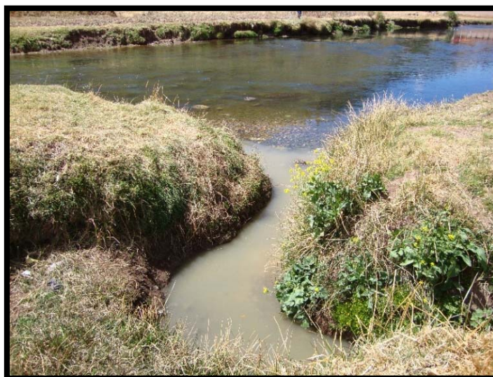
Figura N°6. 3 Aguas residuales que se vierten directamente al río Vilcanota en el distrito de Tinta, 2019.
