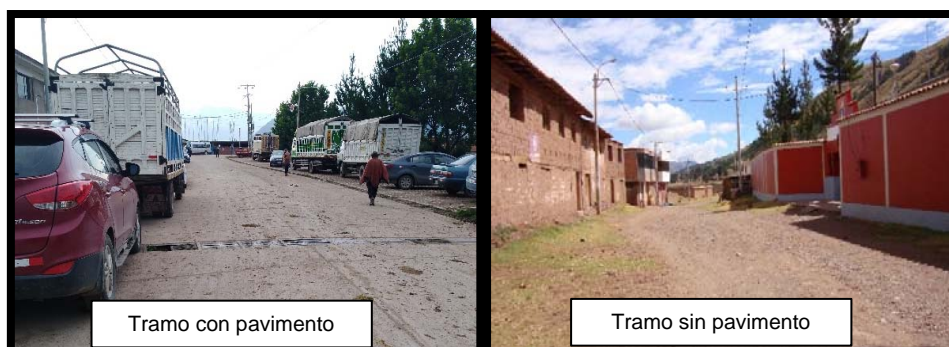
Figura N°A6. 11 Tramos de la carretera antigua dentro del pueblo de Tinta, 2019.
