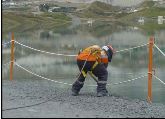
Figura N°1: Operario retirando el residuo de material granular con una pala a ras del suelo
