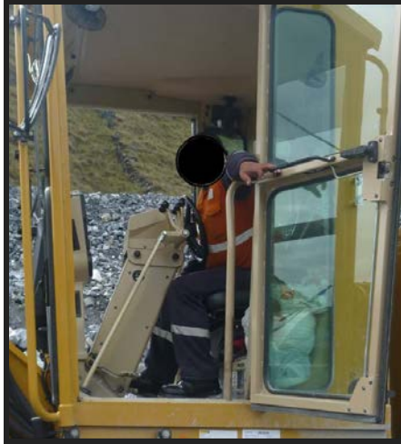
Fuente: Construcción de la Elevación de la Presa de Relaves
