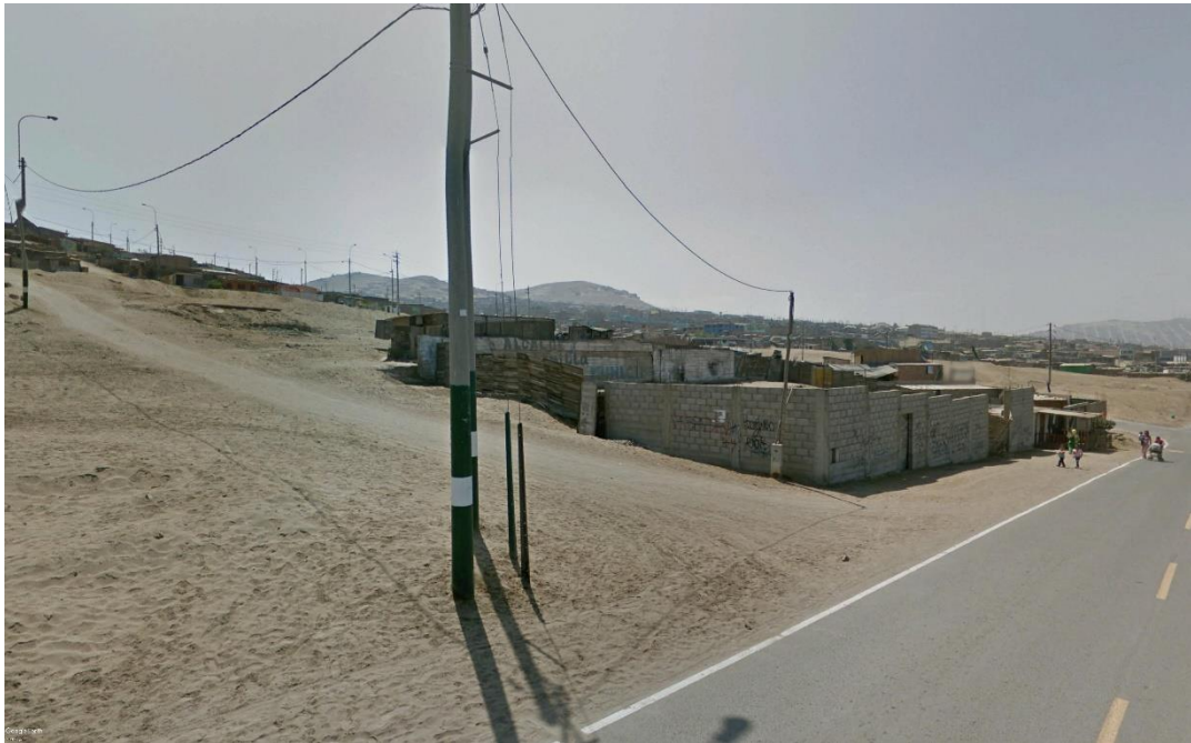
FOTO DESDE LA AVENIDA E
