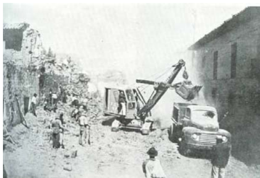
29- Trabajos de remoción de escombros. Chambi
