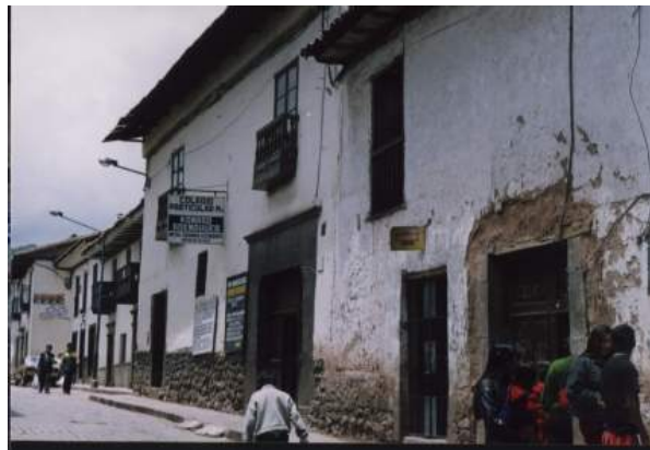
82. Calle Nueva Alta. Archivo Propio
