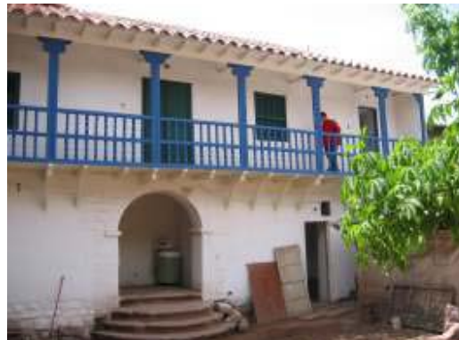
110- Casona Manz. nº 127 después de la Intervención. CGP. 2005
