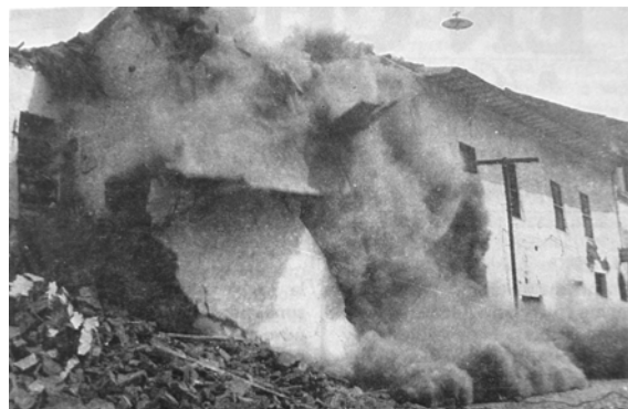
30- Trabajos de remoción de escombros. Chambi
