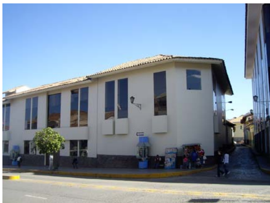
70- Local de Entel Perú, actual Telefónica. Archivo Propio
