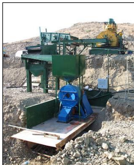
Figura 6.8. Instalación de planta concentradora centrífuga.
