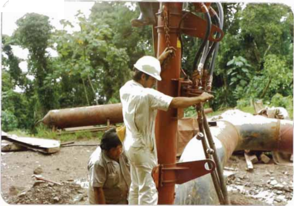
FIG. 14.- Instalación de la máquina taladradora en la Margen Izquierda.
