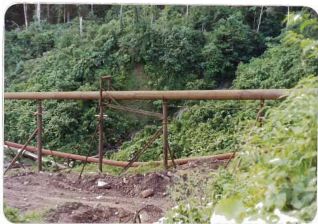
FIG. 3.- Vista de la parte central sobre la quebrada, se observan la tubería de reemplazo, la tubería by-pass y parte de la línea del Oleoducto.
