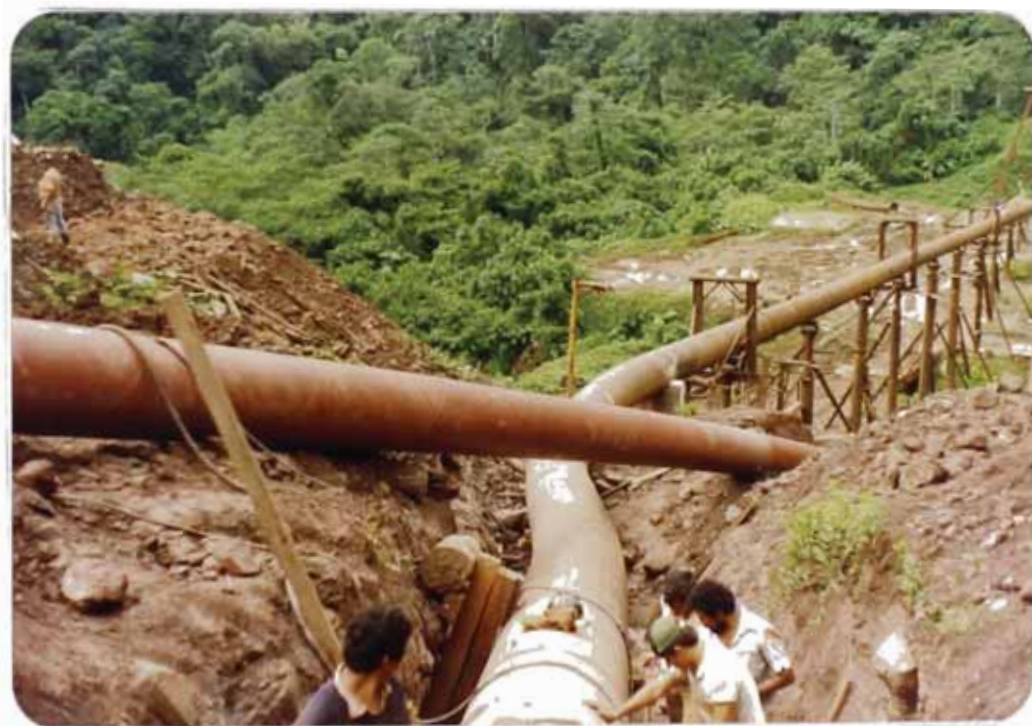
-FIG.7.- Vista de la margen izquierda, se aprecia los dobleces tanto horizontales como verticales en la tubería de reemplazo, con dirección al empalme con el Oleoducto.
