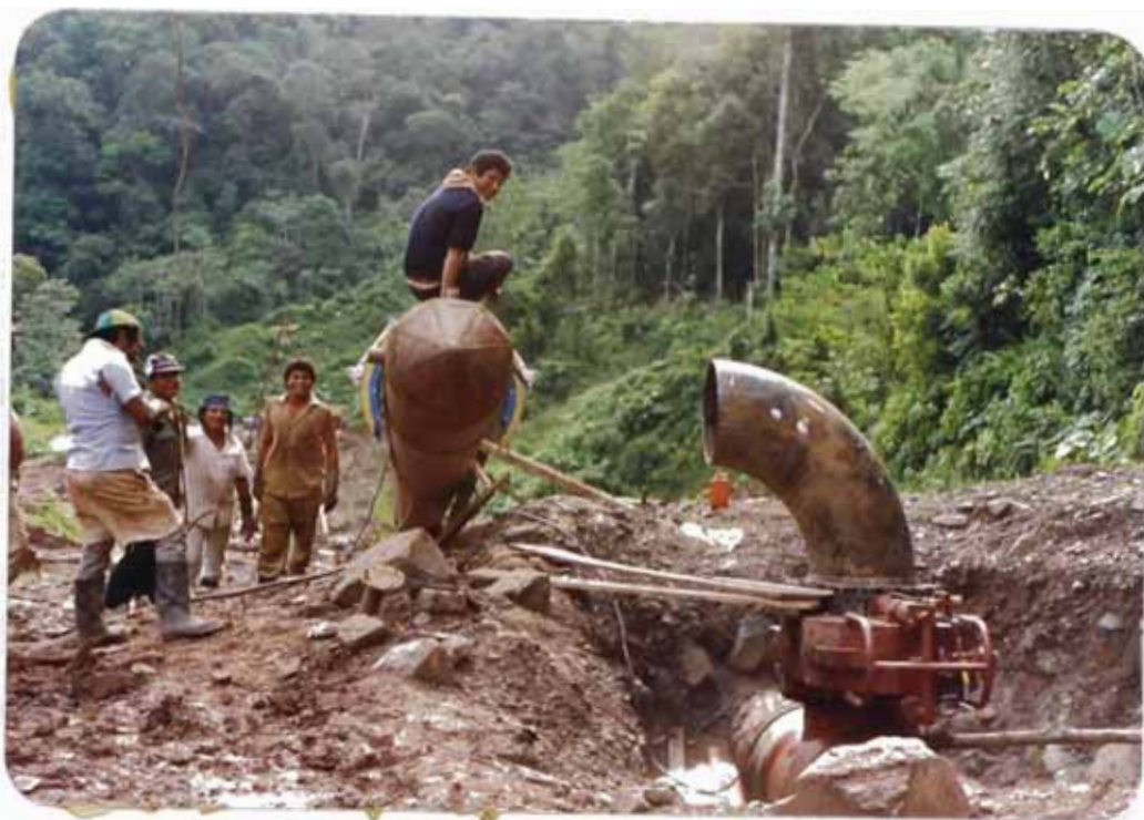
FIG. 10.- Vista de la margen izquierda, se observa el codo colocado sobre la válvula sandwich para su conexión con la tubería by-pass.
