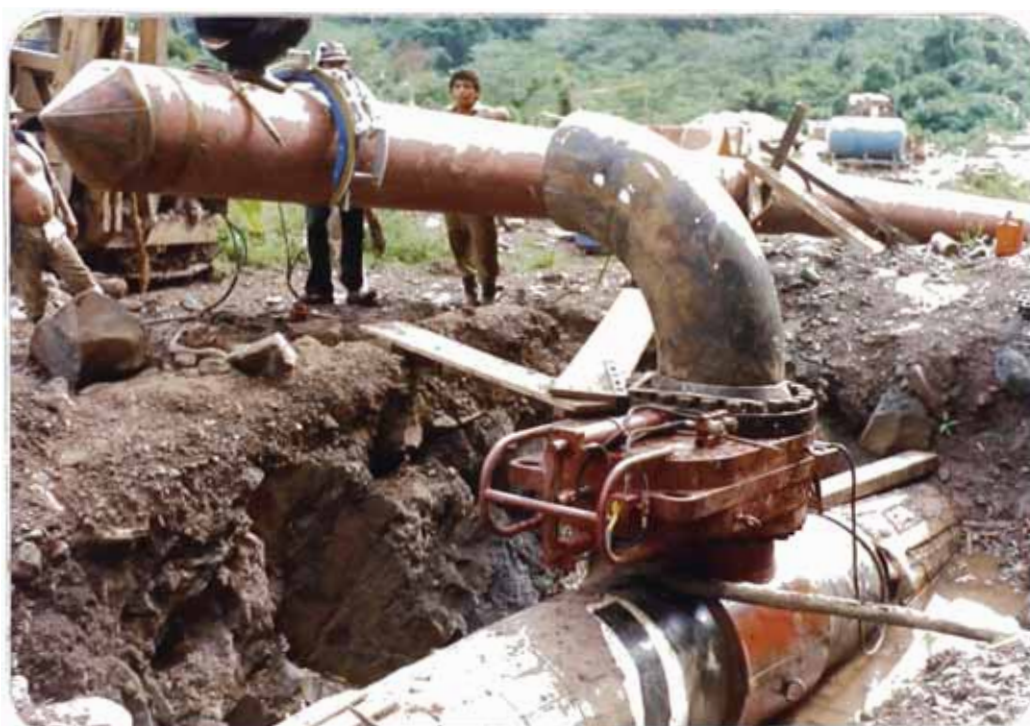
FIG. 11.- Vista de la margen izquierda, se observa la tubería by-pass a ser cortada para su unión con el codo conexión con la tubería de oleoducto.
