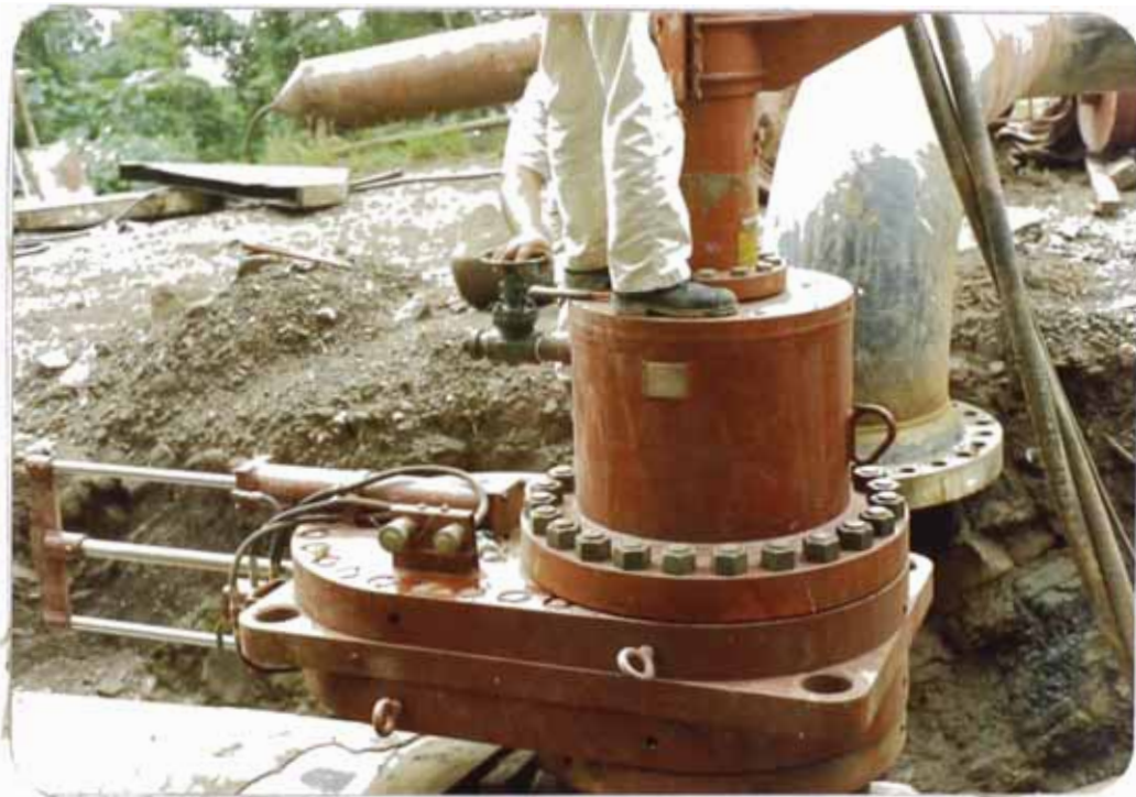
FIG. 15.- Máquina Taladradora instalada sobre la válvula sandwich.
