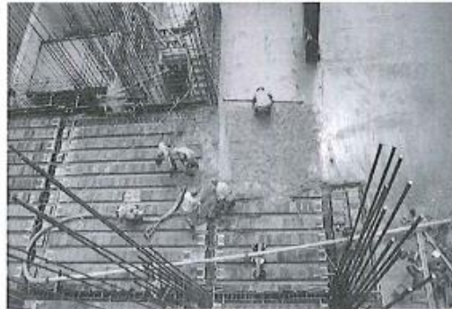
Vaciado en elementos horizontales
