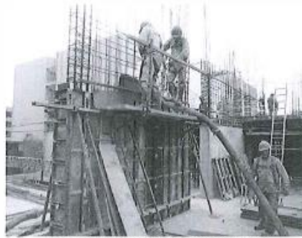
Vaciado de elementos verticales
