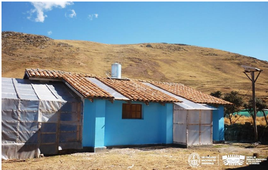
Figura 6. Imagen de la vivienda bioclimática construida en la comunidad San Francisco de Raymina, Ayacucho-Perú (CER-UNI, 2012).
