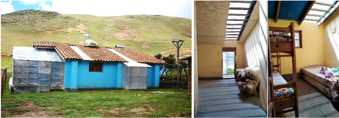
Figura 41. (Izq.) Vista frontal del Albergue comunal bioclimático. (Der.) Vista interior de la sala y de dormitorios.
