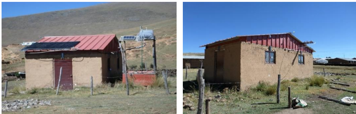
Figura 42. Vista del Módulo Experimental de Vivienda (MEV).
