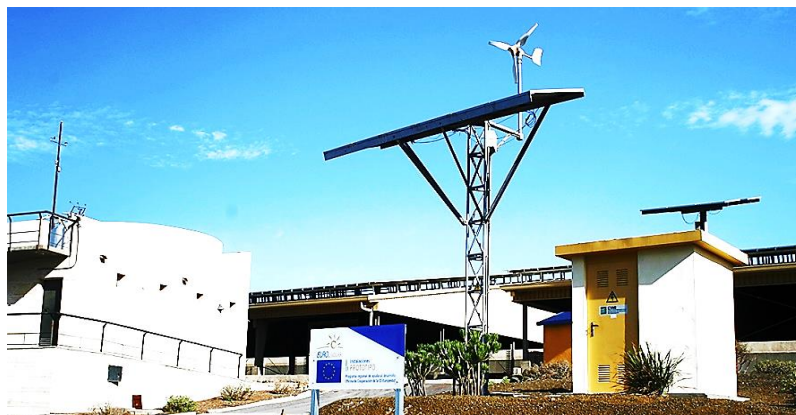
Figura 5. Vista de instalación de kit híbrido eólico-solar de 1,4 kW (ITER, 2011).
