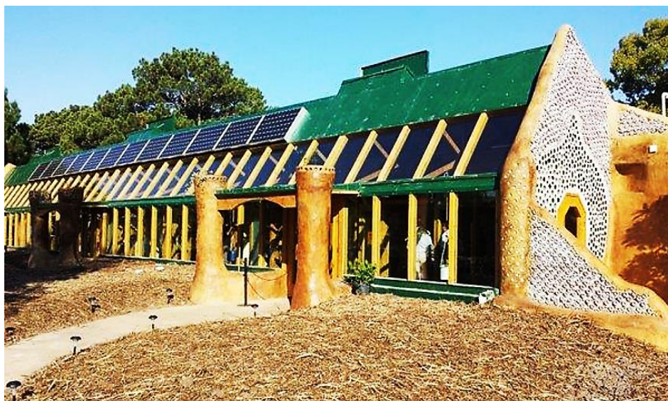
Figura 3. Vista de la escuela rural sustentable construido en Uruguay (OMEP, 2016).
