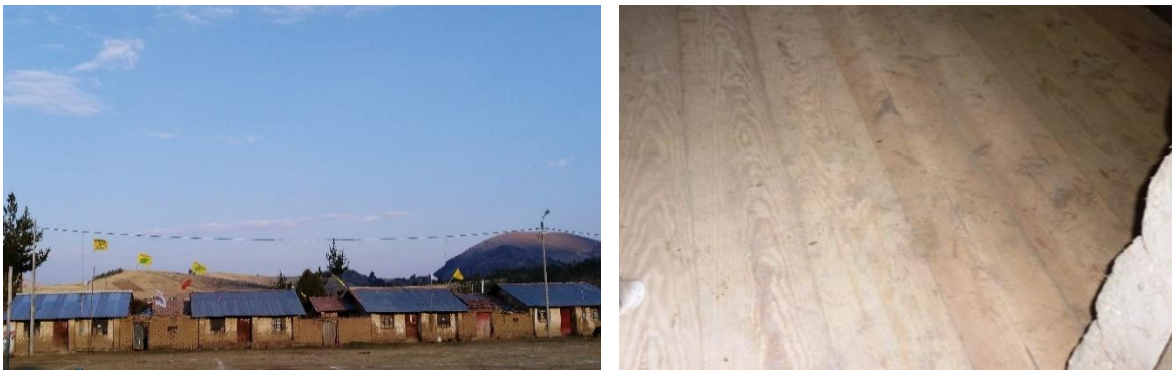
Figura 43. (Izq.) Vista de viviendas que cuentan con techos aislados térmicamente con lana de oveja. (Der.) Vista de vivienda que presenta aislamiento higrotérmico de pisos.
