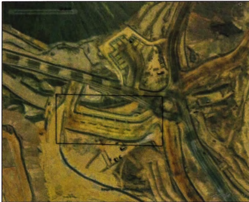
Figura 4,32 Vista satelital de las bahías "Culvert 3".
