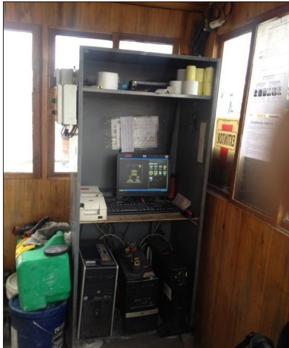
Figura 5. Instalación de PC's en grifos
