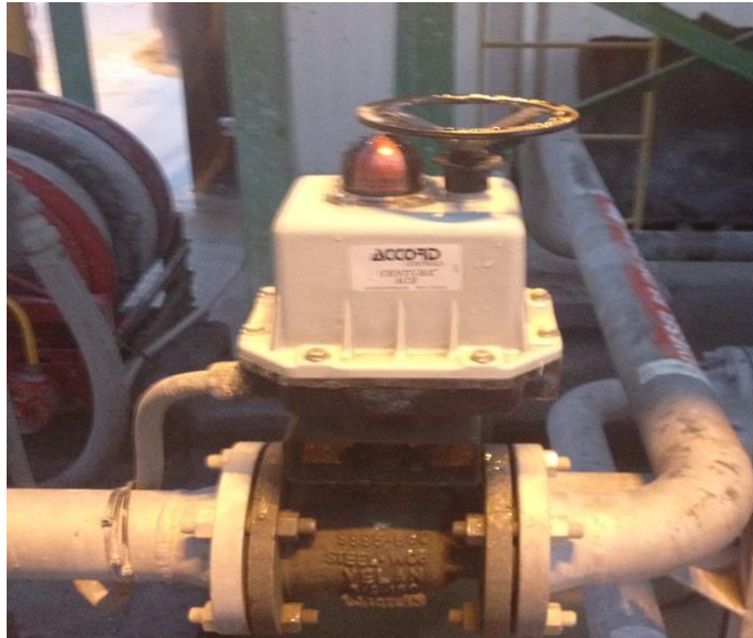
Figura 27. Electroválvula (Fuente Repsol).
