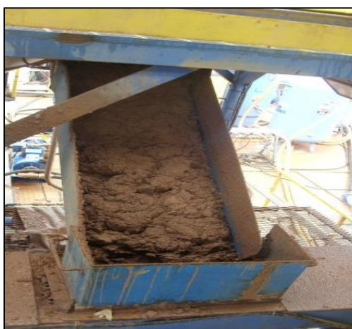
Figura 3.12. Sólidos, obtenidos luego del Dewatering.
