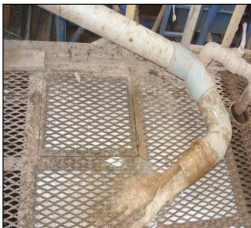
Figura 3.11. Efluente proveniente del lodo de perforación después del Dewatering.
