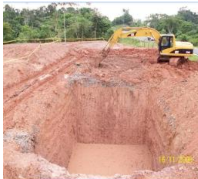
Fig. 8.1. Construcción de celdas de remediación de suelos
