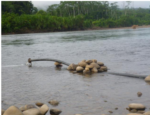
Figura 1.1 Línea de Descarga del efluente tratado hacia el cuerpo receptor.
